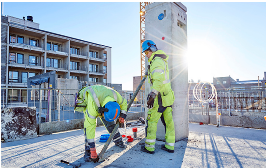
KUVA 7. Elpo-talotekniikkaelementtejä asennetaan Skanska Talonrakennus Oy:n työmaalla Helsingin Lauttasaaressa (Rudus Oy, 2017)
