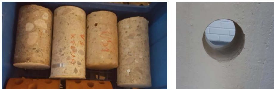
Kuva 4. Teräsbetoninäytteet ja näytteenotto kohta.
