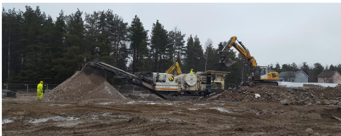
Kuva 8. Kaivinkone siirtää betonijätettä leukamurskaimeen
