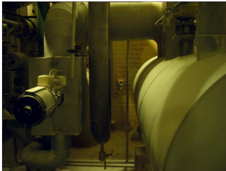
KUVA 16 Uusi lähetin asennettuna putkiston keskelle. (Juha Pölkki, 2010.)
