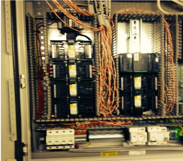
Kuva 12. Ilmanvaihtokonehuoneen valvonta-alakeskus.
