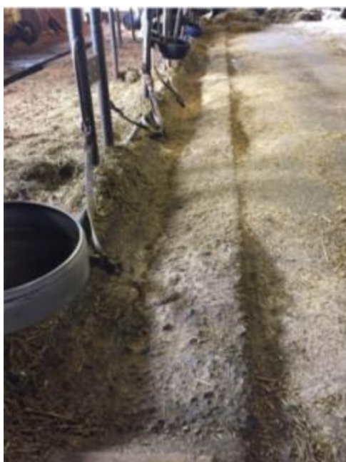
KUVA 5. Liian kulunut ja vaikeasti puhtaana pidettävä ruokintapöytä (Itä-Suomen aluehallintovirasto 2016-10-24).
