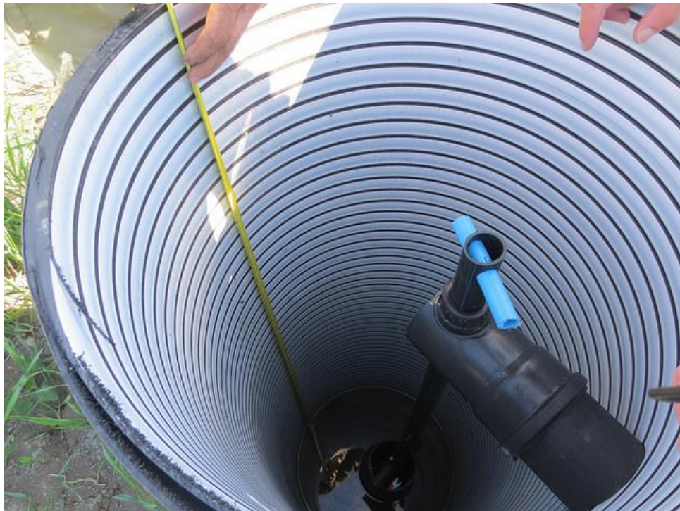
Kuva 11. Säättökaivon vedenkorkeuden mittaaminen. (Katariina Manni 2016)
