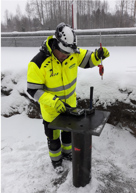
Kuva 18. Mittamies asettaa hitsattavan levyn putkipaalun päälle millin tarkkuudella.
