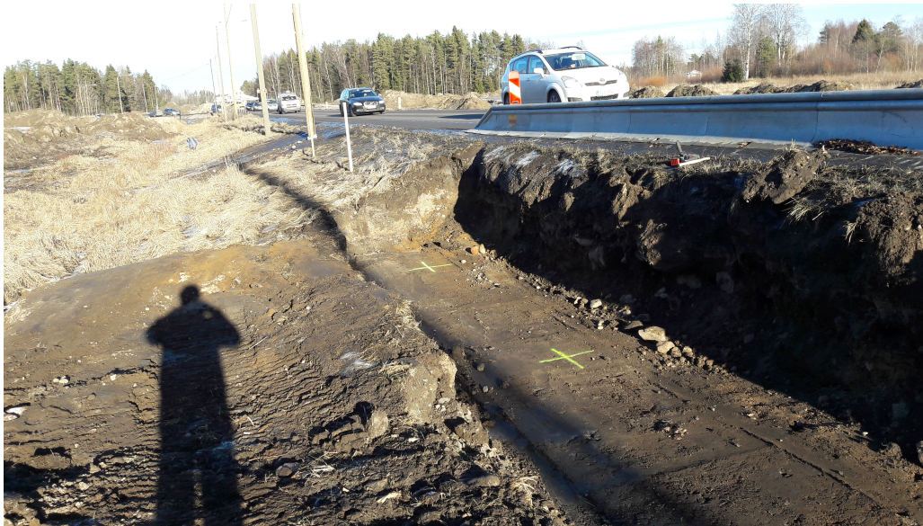
Kuva 14. Kaivu-ura, johon merkattu paalujen paikat
