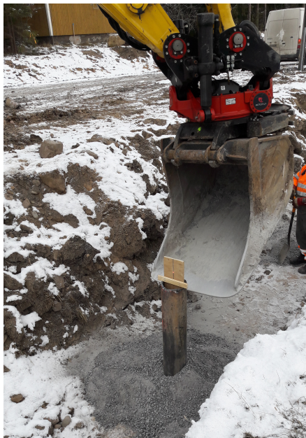
Kuva 17. Putkilasersäde näkyy mittalevyssä. Kaivinkone asettaa paalun kohdalleen.
