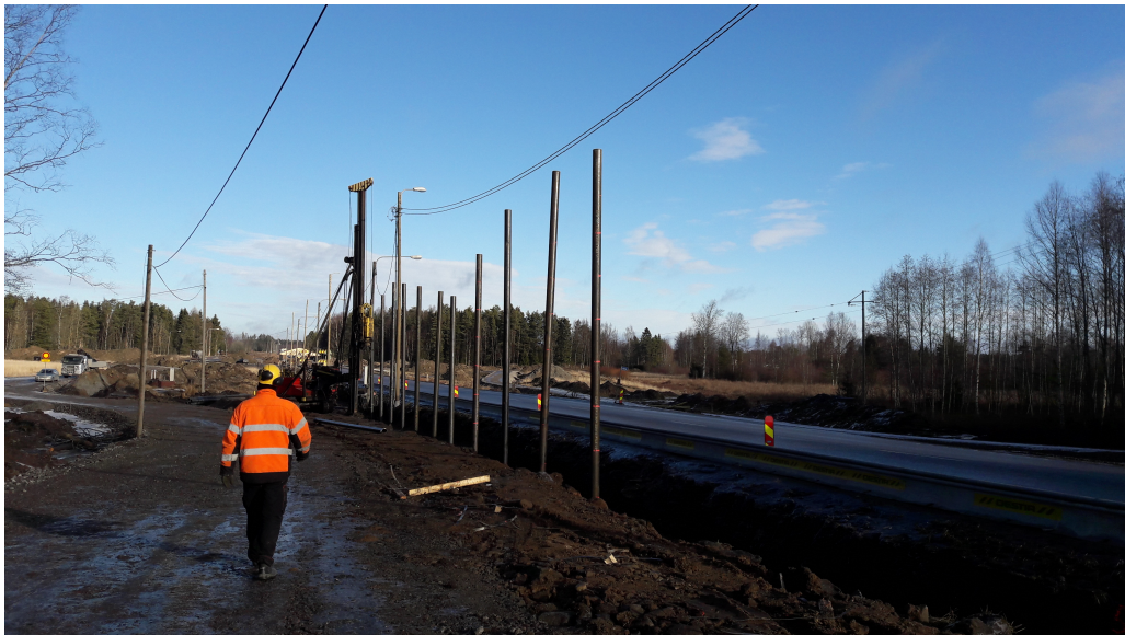
Kuva 15. Paalut ennen katkaisua, kuvissa myös paalutuskone
