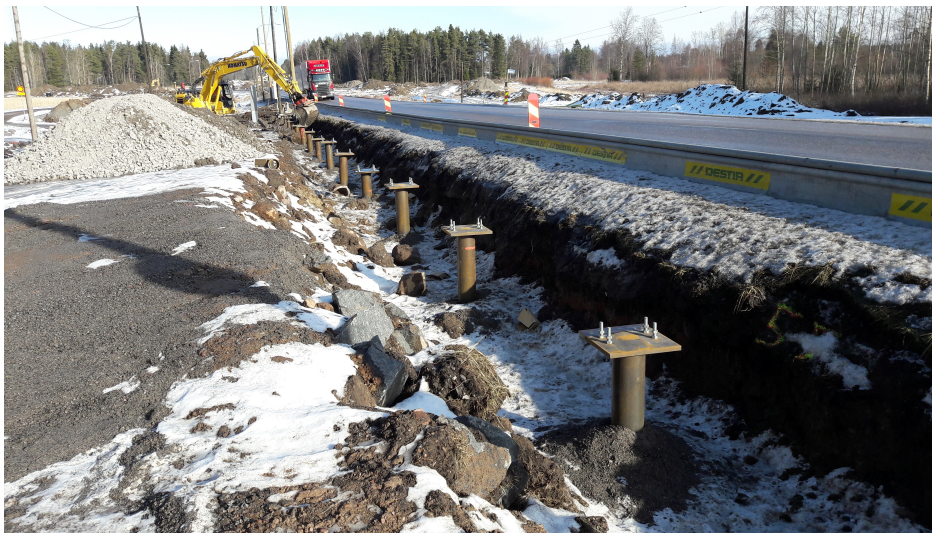
Kuva 19. Kerroksittainen mursketäyttö aloitettu ja levyihin asennettu kiinnityspultit
