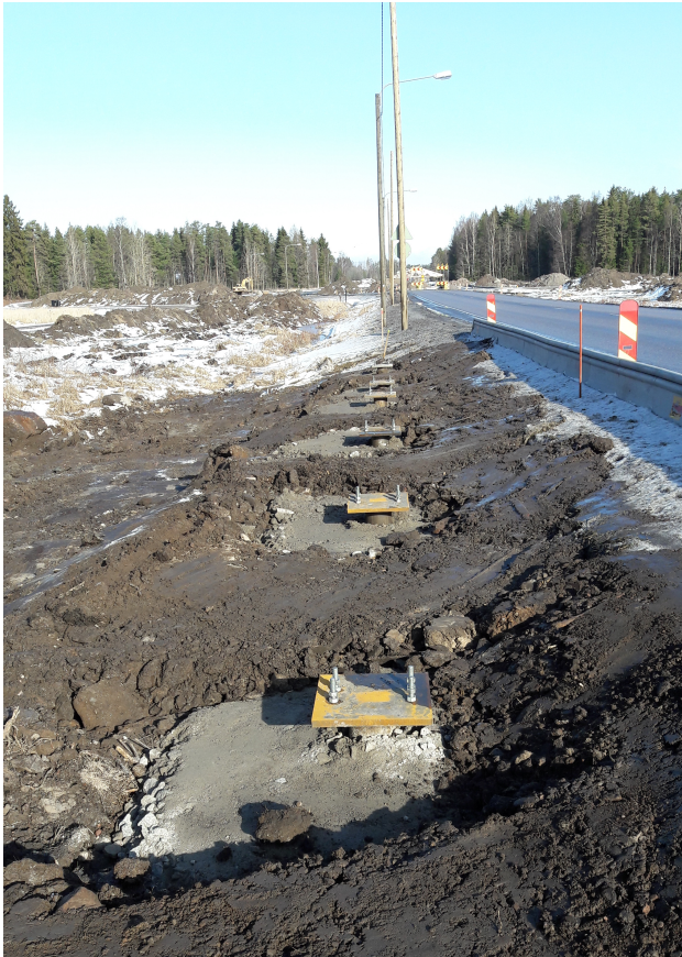
Kuva 20. Tähänastiset maatyöt ovat valmiit. Luiskien muotoilu ja multausta tehdään aitaelementtien asennuksen jälkeen keväällä 2017.
