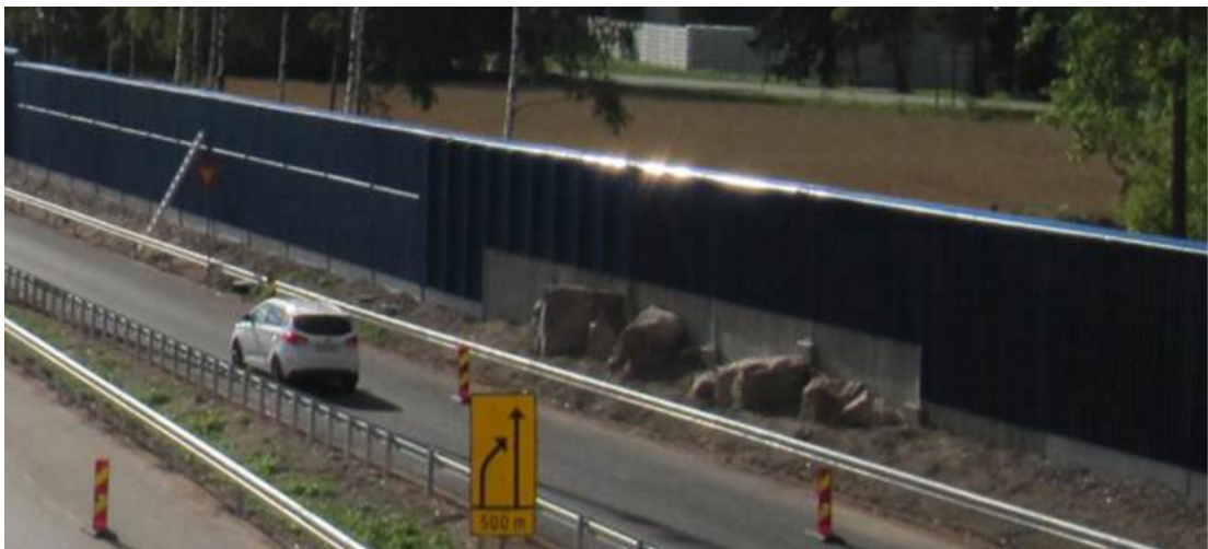
Kuva 12. Kuvassa näkyvät kalliot oli kartoitettu, mutta niiden korkeussijainnin arviointi epäonnistui. Kalliot nousivat osittain pystysuoraan ylöspäin, jolloin meluseinäelementtiin jouduttiin tekemään kuvassa näkyvät muutokset.
