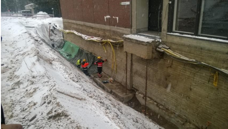
Kuvio 11. Kellarin maanpaineseinän ulkopuolen korjaustyöt (Hirvelä 2017a)
