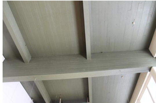
Kuva 38. Toimiston 162 katto, tuuletusputken pää puuttuu, seinän ja yläpohjan raosta valunut hiekkaa?
