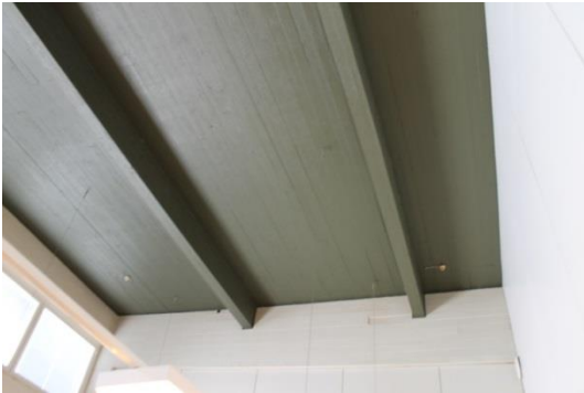
Kuva 38. Toimiston 162 katto, tuuletusputken pää puuttuu, seinän ja yläpohjan raosta valunut hiekkaa?
