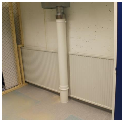
Kuva 2. Radonputki
