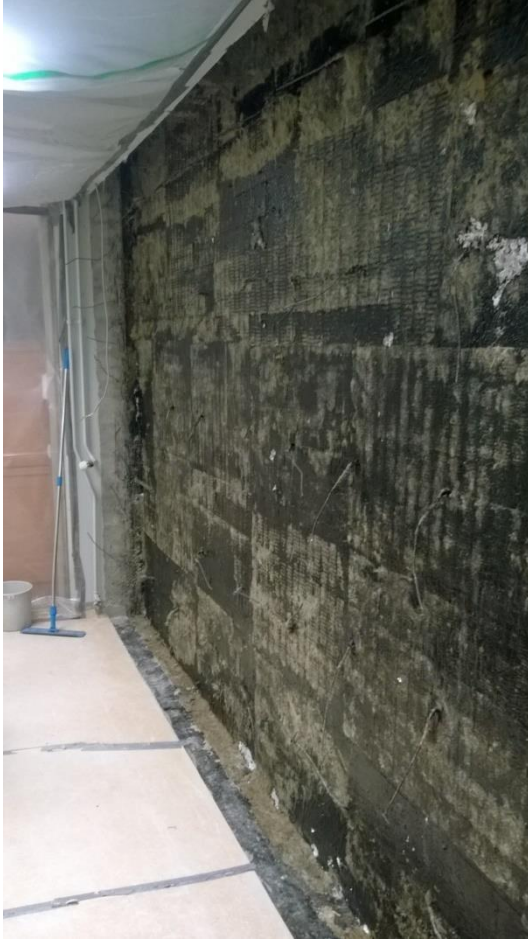
Kuvio 9. Kellarin maanpaineseinän vesieristeenä toimiva bitumisively (Hirvelä 2017a)
