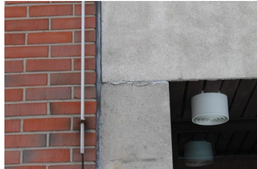
Kuva 43. Halkeama julkisivussa itään
