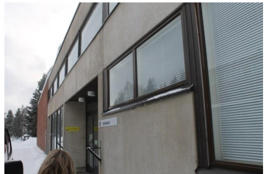
Kuva 57. Vanhan ikkunan vesipellitys kerää lunta
