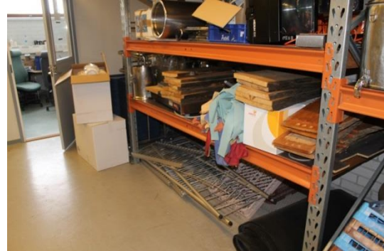
Kuva 27. Varastossa 030 hyllyjen alla kulkeva putkikanaali
