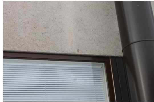
Kuva 49. Revennyt saumaus julkisivussa länteen
