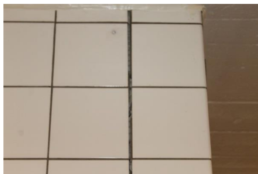
Kuva 74. Halkeama voimistelusalin seinässä
