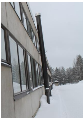
Kuva 1. Radonin poistoputki
