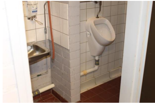
Kuva 160. Vuotava putki
