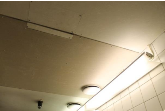
Kuva 99. Halkeama naisten wc oven yläpuolella
