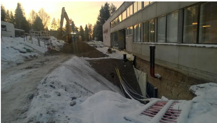
Kuvio 10. Kellarin maanpaineseinän ulkopuolen korjaustyöt (Hirvelä 2017a)
