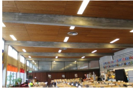
Kuva 32. Pilari-palkki-runko sali 138
