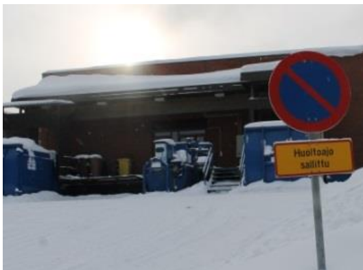
Kuva 63. Keittiön päädynlastauslaiturin katos
