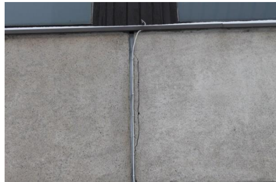
Kuva 43. Halkeama julkisivussa itään
