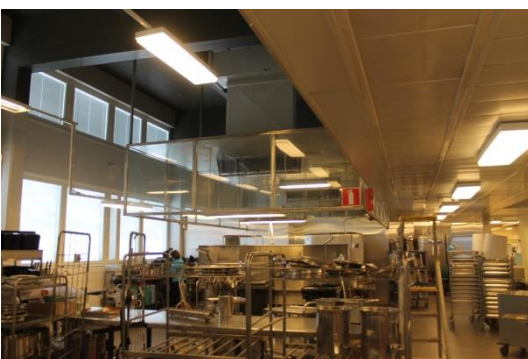
Kuva 163. Keittiössä 104 poistohuuvat väärässä paikassa
