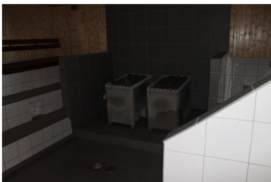
Kuva 152. Saunan sähkökiukaat
