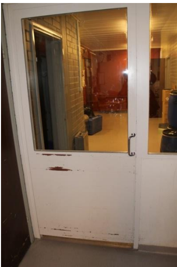
Kuva 89. Sotilaskodin keittiön ovi
