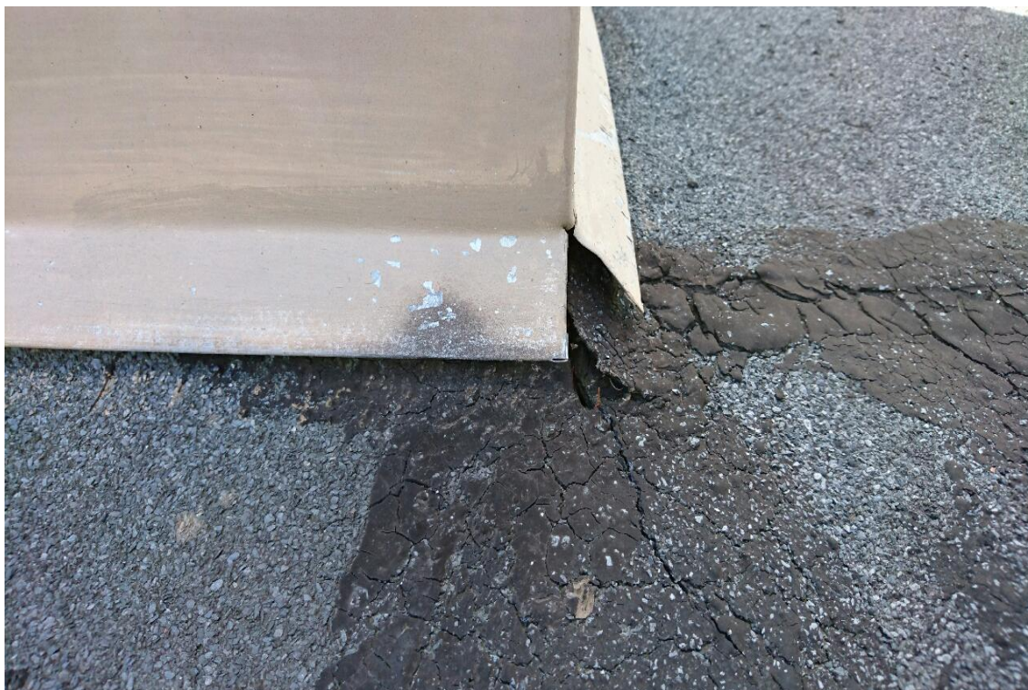
Kuva 12. Laajennusosan piipun juuren liittyminen vesikatteeseen.
