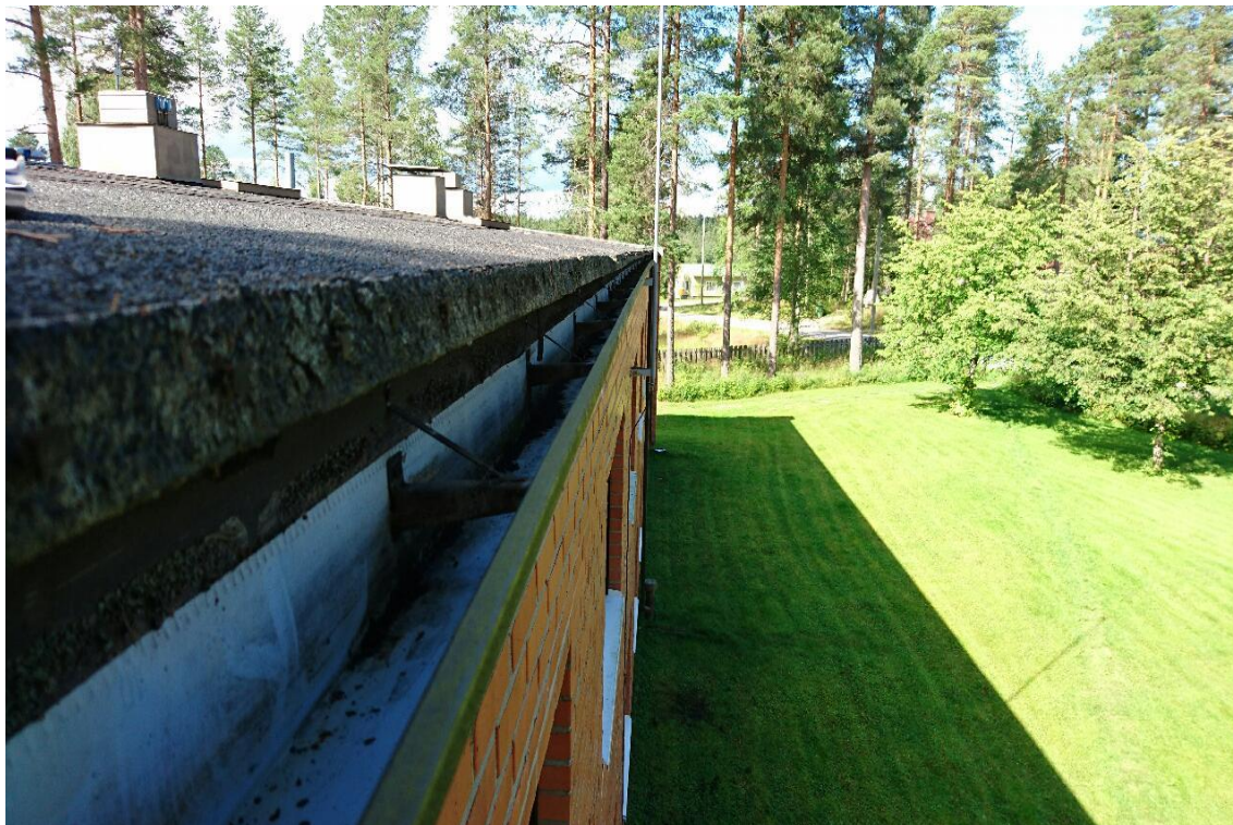
Kuva 13. Laajennusosan räystääs ja vesikouru.
