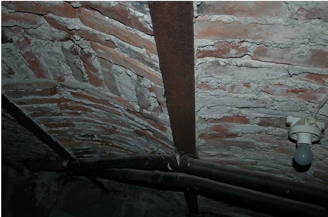
Kuva 42. Kellarikerroksen vanha kappaholvirakenne.
