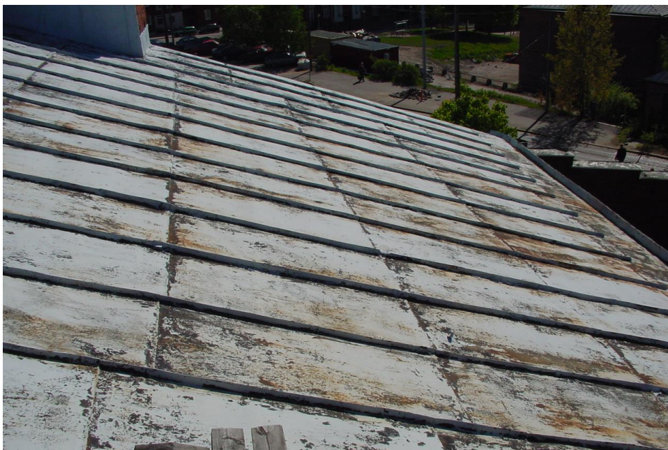
Kuva 47. Vanhan vesikaton kunto.
