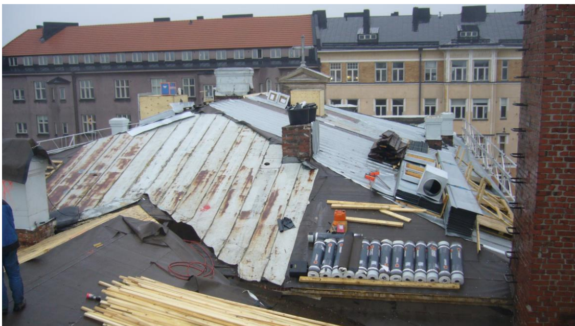
Kuva 48. Vanhan peltikaton uusiminen käynnissä, jossa kermialuskate on koko kattoalueella.
