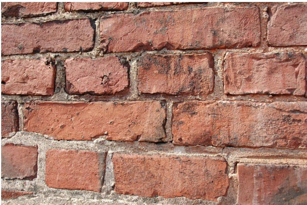
Kuva 45. Massiivinen tiilimuuriseinä.
