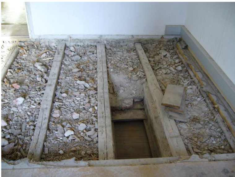
Kuva 43. Vanha avattu puuvälipohjarakenne.
