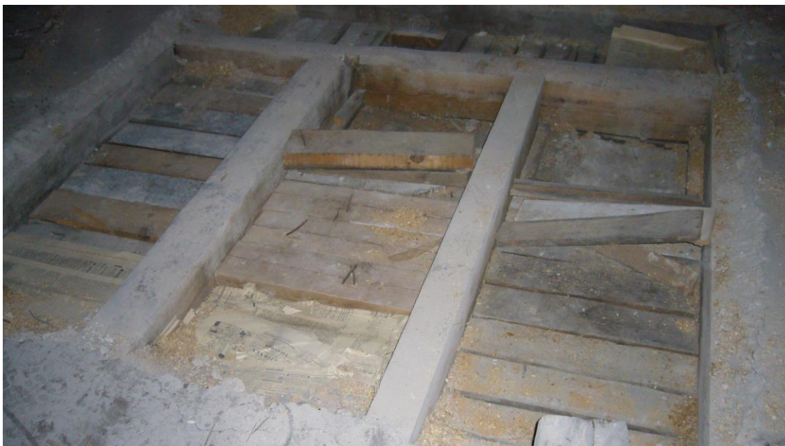
Kuva 46. Avattu vanha puuyläpohjarakenne.
