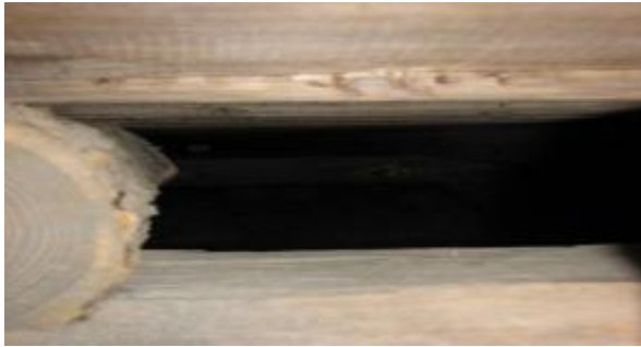
Kuva 6. Alapohja tuuletusaukolta katsottuna
