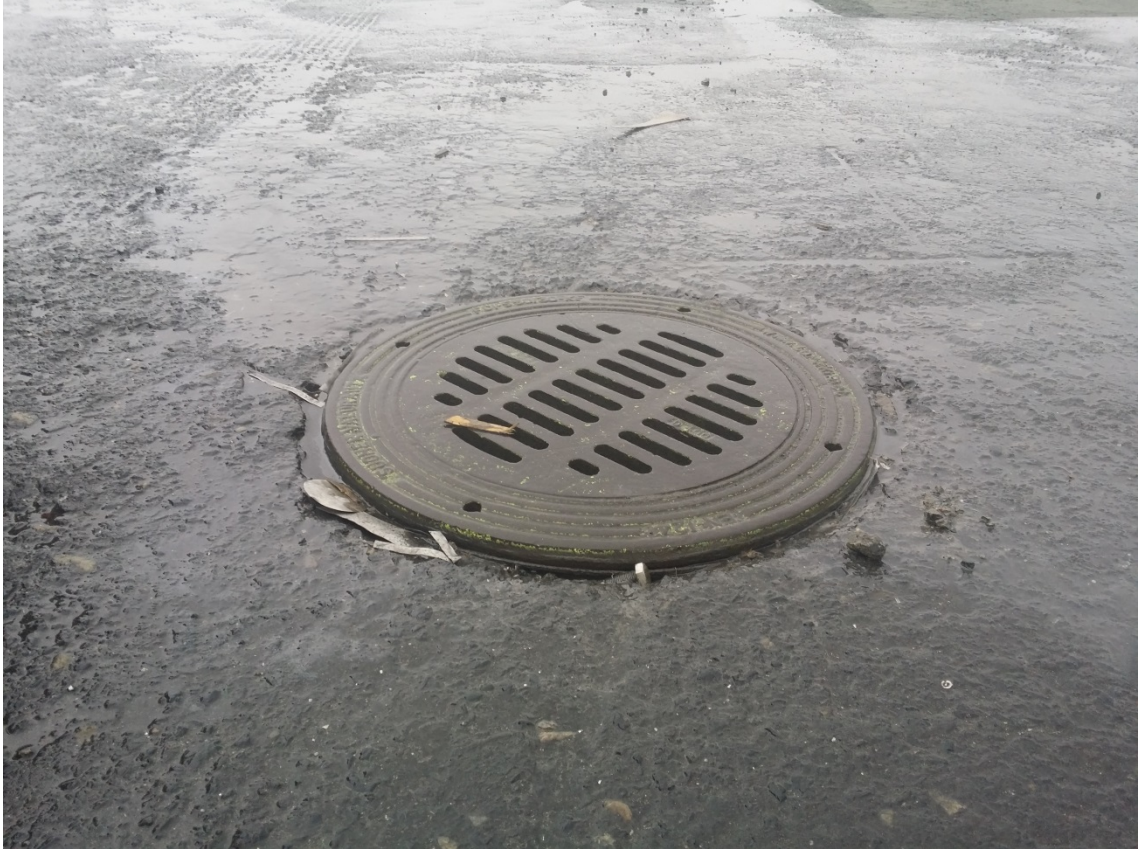
Kuvio 25. Kansisto huomattavasti korkeammalla kuin asfaltin pinta
