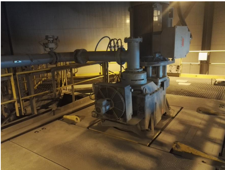
KUVA 8. Vaihdelaatikon jäähdytyspuhallin
