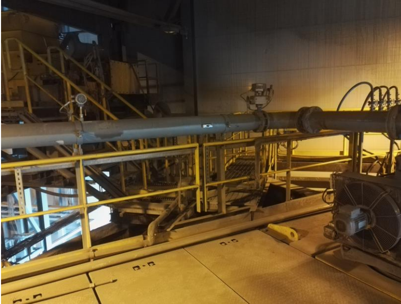
KUVA 10. Ilmavirranmittauksen ja venttiilin sijoituspaikat
