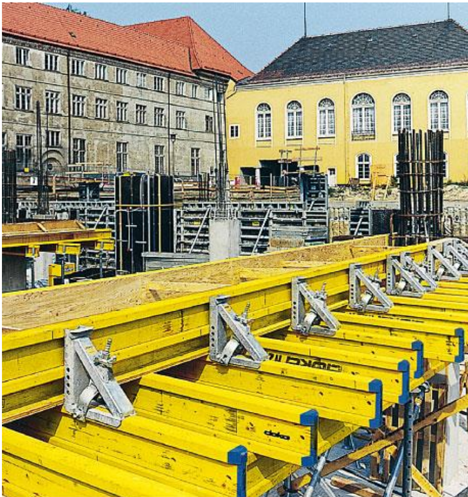
KUVA 16. Palkkisoljilla tuettu muotin reuna (Kuva: Doka Finland)
