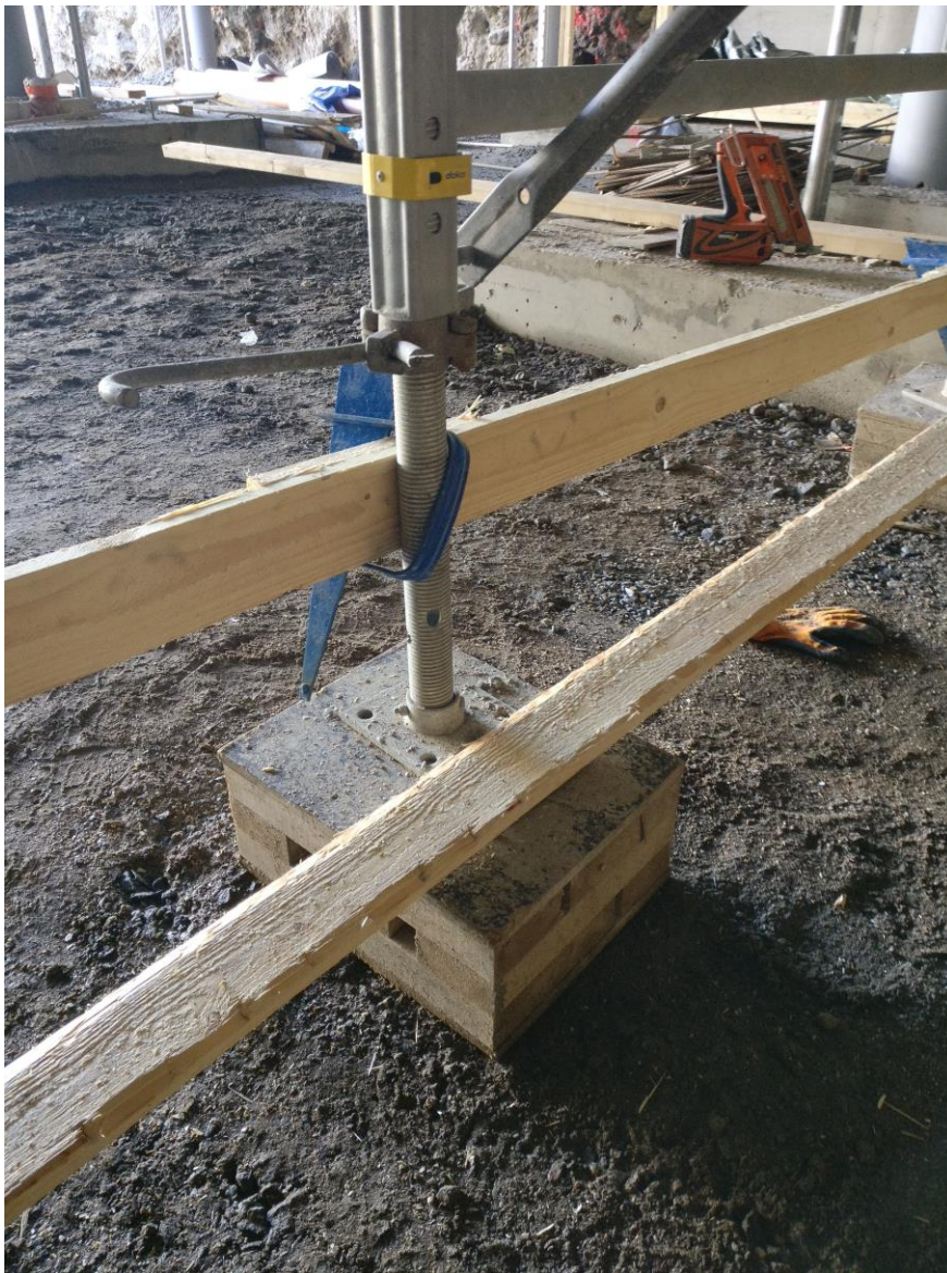
KUVA 9. Maapohjalle pystytetyn tukitornin jalan alle tulee tehdä tukeva peti
