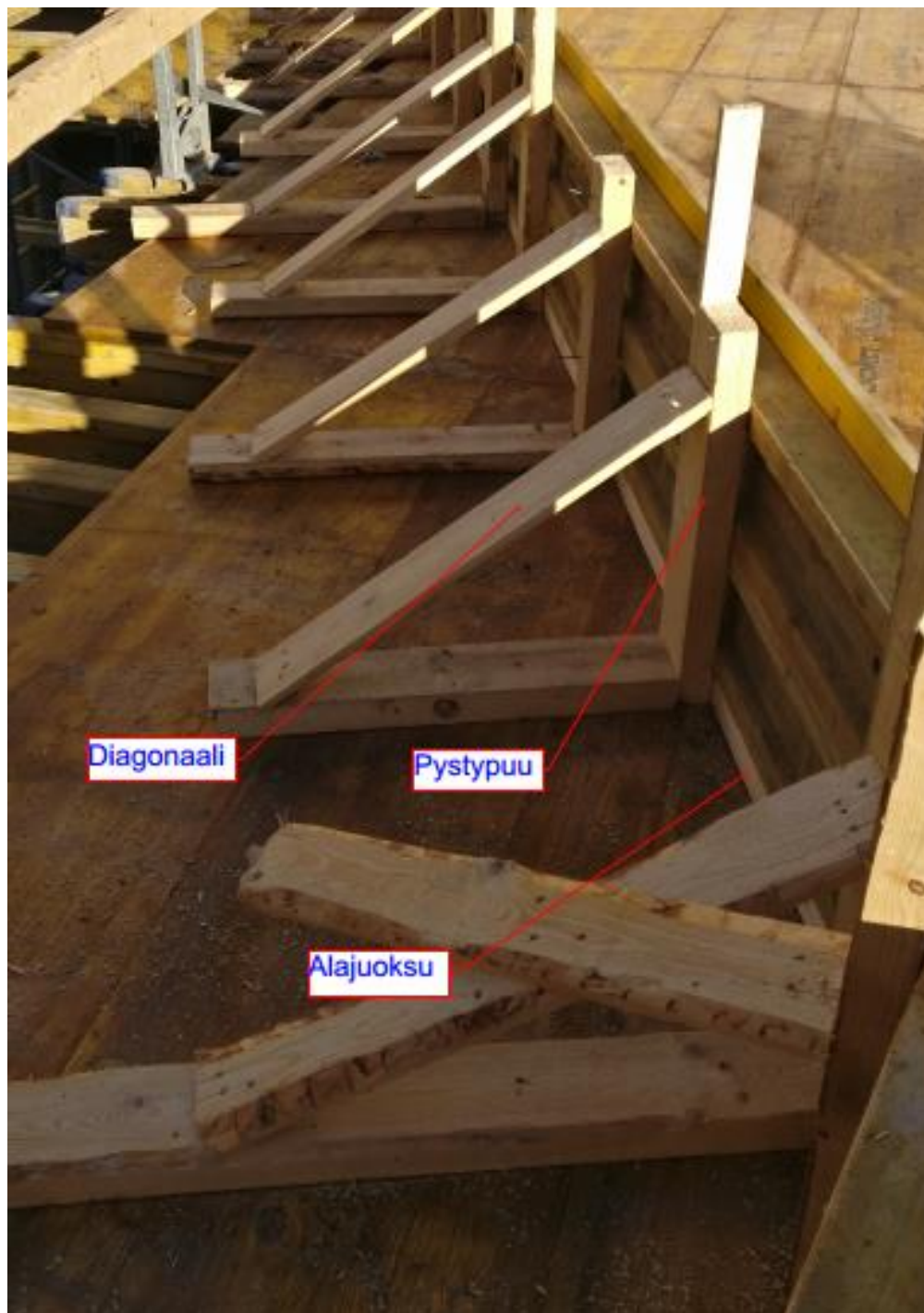
KUVA 17. Muotin reunan tuenta puutavaralla
