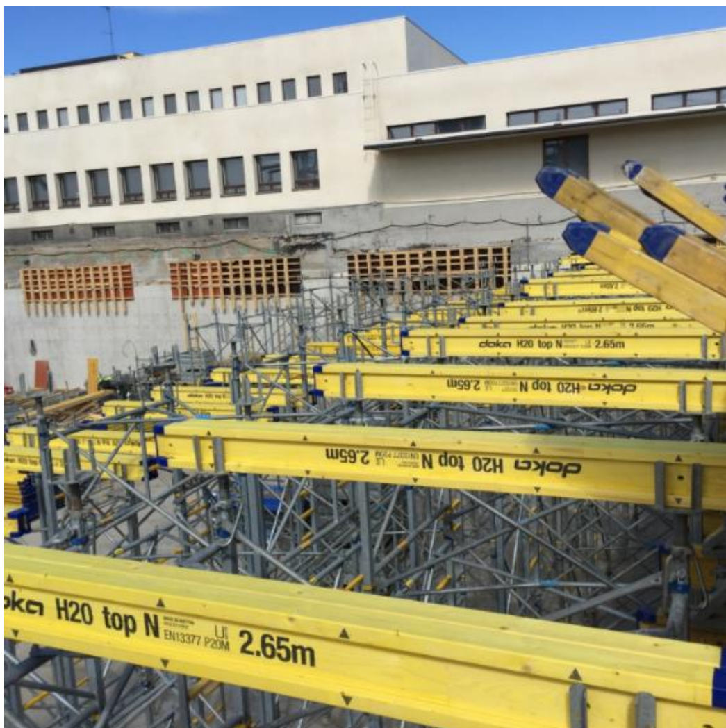
KUVA 12. Kruunuihin asetettuja niskapalkkeja (Kuva: Sami Oldén)
