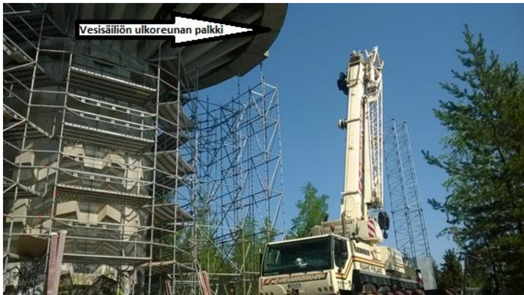
Kuva 12 Linkkimaston kasaus Porvoon vesitornin vieressä
