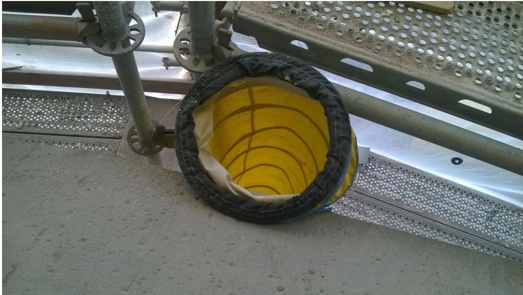
Kuva 21 Lämmittimen puhallinletkun pää
