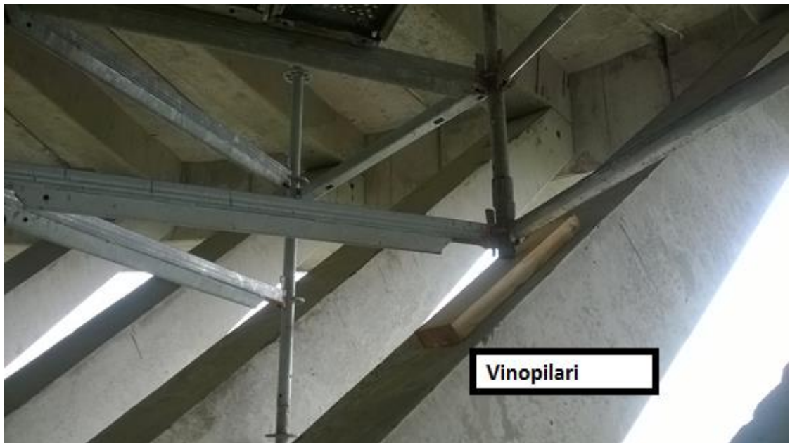
Kuva 13 Telineiden vääränlainen tuenta vinopilareihin
