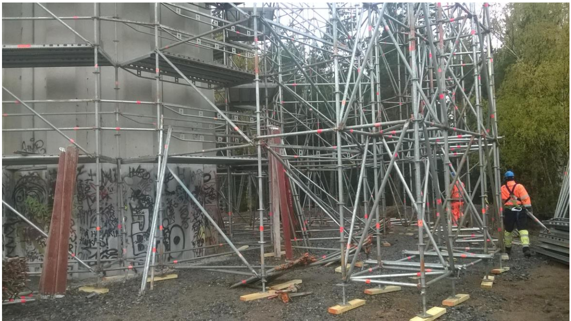
Kuva 11. Tukitornin ja uloimman kehän rakennus
