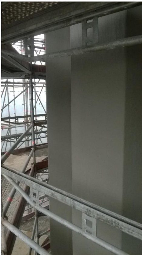
Kuva 17 Työtaso liian kaukana kohteesta
