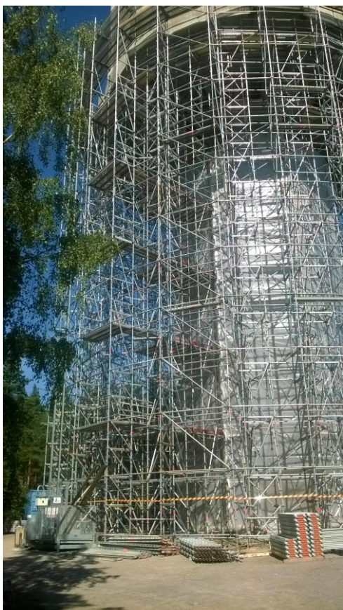
Kuva 23 Tammisaaren jalan sääsuojaus
