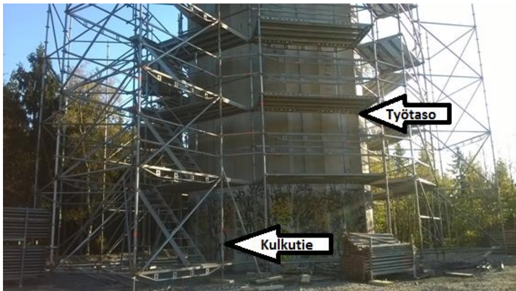
Kuva 9 Vesitornin telineiden sisimmäinen kehä
