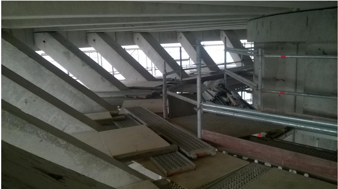
Kuva 14 Porvoon vesisäiliön pohjan telinetaso
