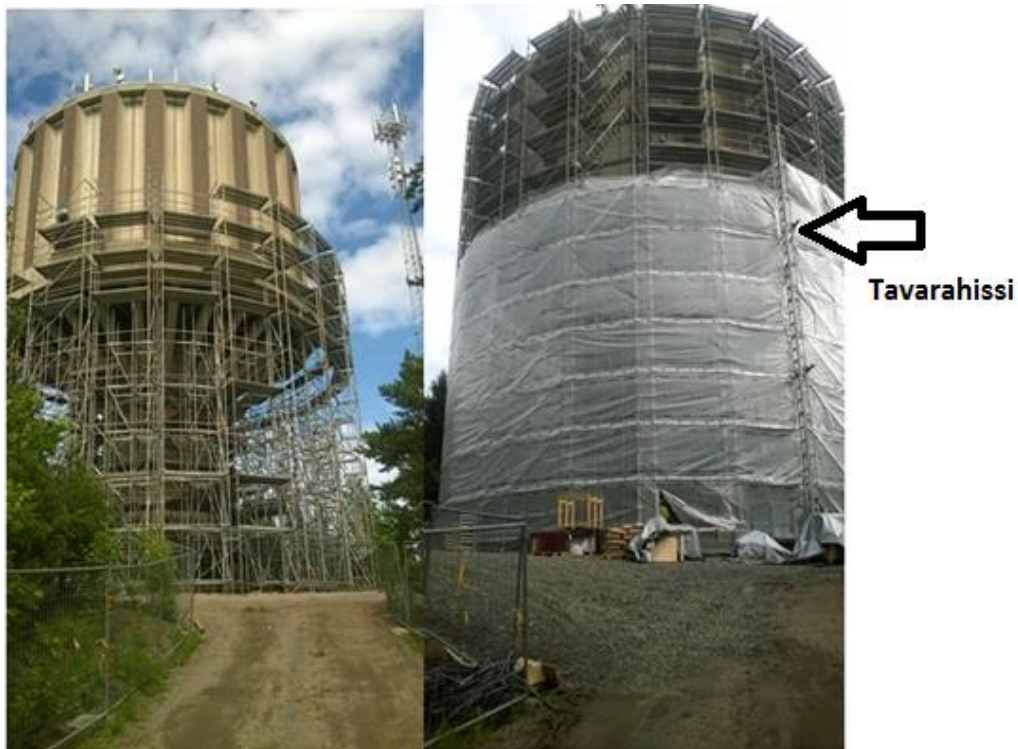
Kuva 15 Porvoon vesitornin uloimman kehän rakentaminen (vasemmalla) johon sääsuojaus kiinnitettiin (oikealla)
