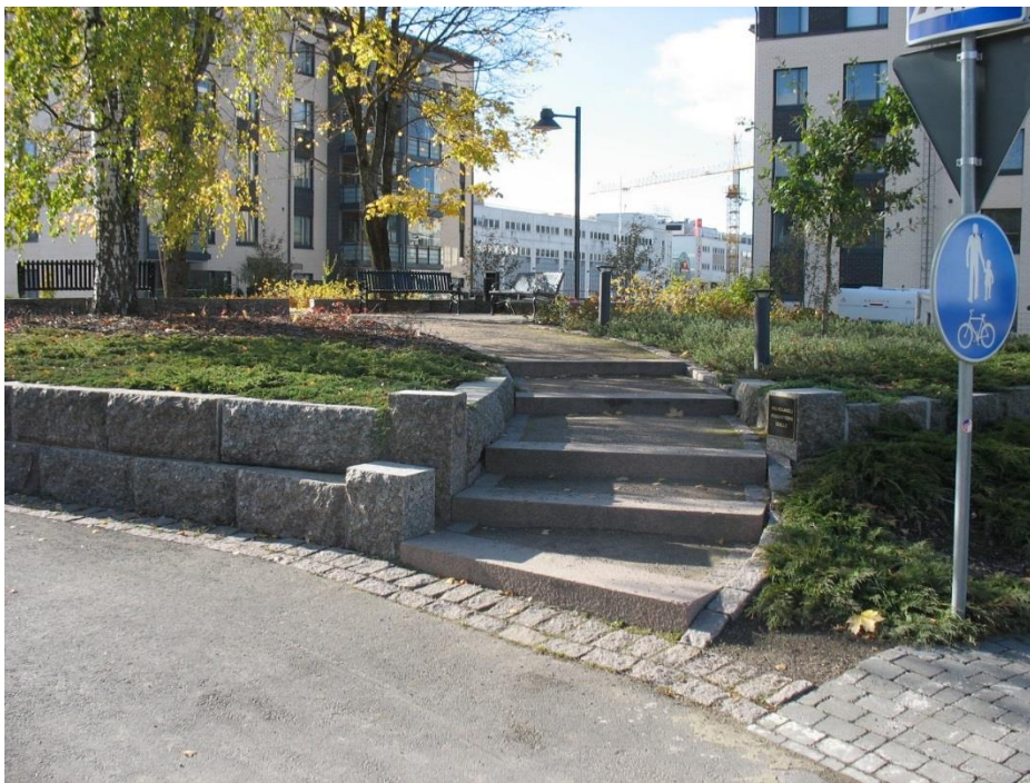
Kuva 7 Massiivikivi nousuna ja tiivistetty sora askelmana (Kuva: Hannu Tolonen, Lappeenrannan kaupunki)
