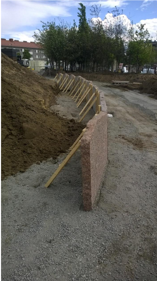
Kuva 16 Poskikivet nojaamassa puupukkeja vasten (Kuva: Miikael Tolonen)
