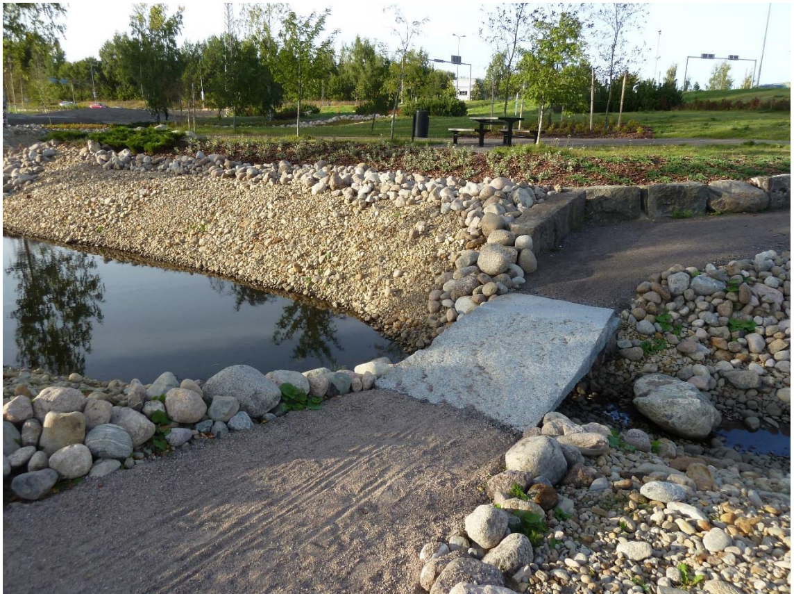
Kuva 23 Poskikivestä tehty silta (Kuva: Hannu Tolonen, Lappeenrannan kaupunki)
