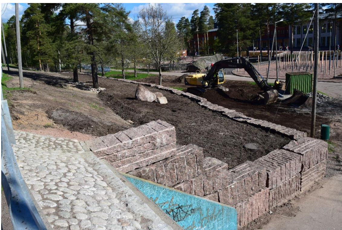
Kuva 21 Sivukiviblokkeja asennetaan päällekkäin (Kuva: Anne Vilkki-Lanu, Kotkan kaupunki)
