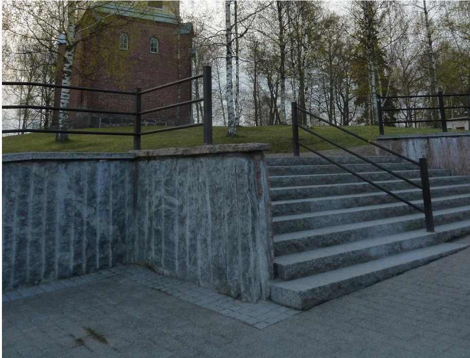
Kuva 8 Massiivikiviportaajat ja vieressä poskikivimuuria (Kuva: Hannu Tolonen, Lappeenrannan kaupunki)
