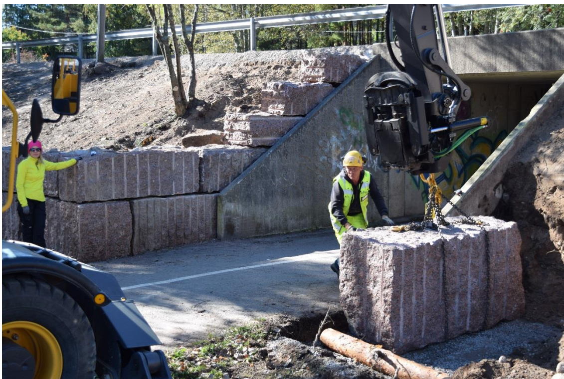
Kuva 21 Sivukiviblokkeja asennetaan päällekkäin (Kuva: Anne Vilkki-Lanu, Kotkan kaupunki)
