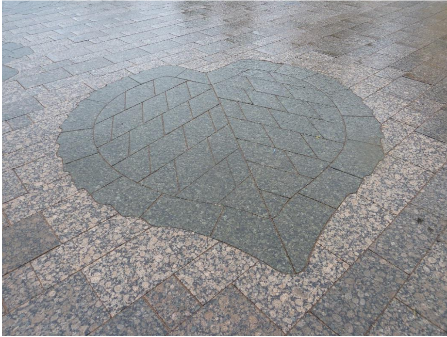
Kuva 3 Yhdistettyjä kivilajeja tasokiveyksessä (Kuva: Anne Veijovuori, Lappeenrannan kaupunki)
