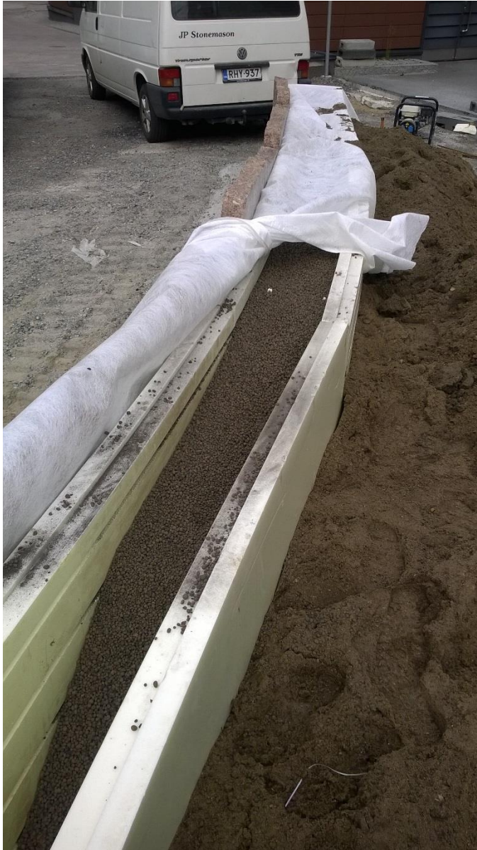
Kuva 19 Poskikivien routasuojaus (Kuva: Miikael Tolonen)
