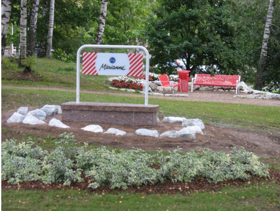
Kuva 10 Poskikivistä rakennettu puistokyltin jalusta (Kuva: Hannu Tolonen, Lappeenrannan kaupunki)
