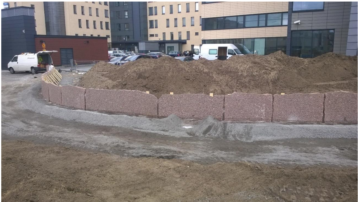
Kuva 9 Sivukivestä tehtyä muuria (Kuva: Miikael Tolonen)
