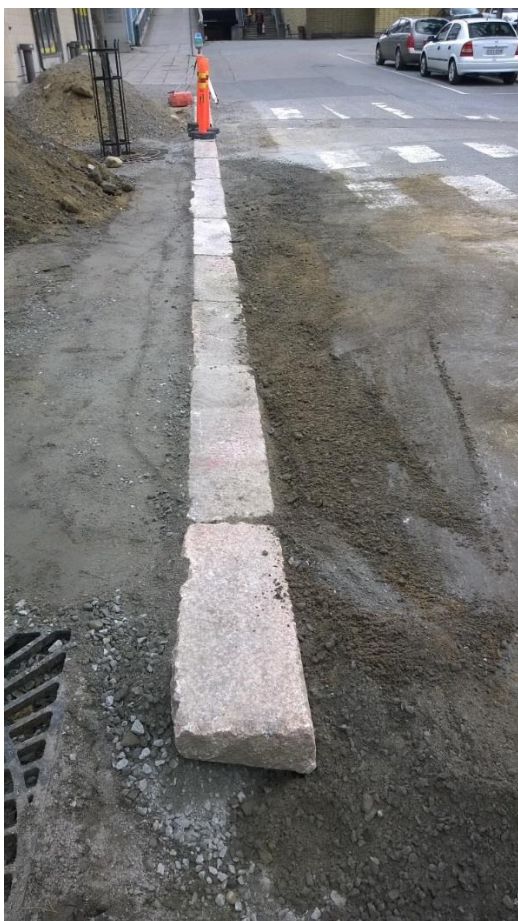
Kuva 5 Suurta reunakiveä asennettu kadun laitaan (Kuva: Miikael Tolonen)
