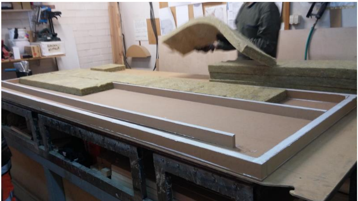
Kuva 12. Äänieristetyin elementin rungon kasausta/liimausta. Alla näkyy elementin siirtoon tarkoitettu mdf-levystä valmistettu ”kelkka”.
