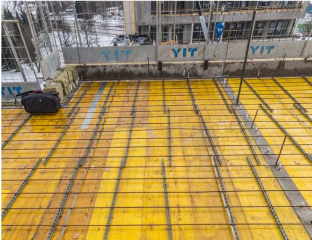
Kuva 8. Bamtec-matto holville levitettyinä
