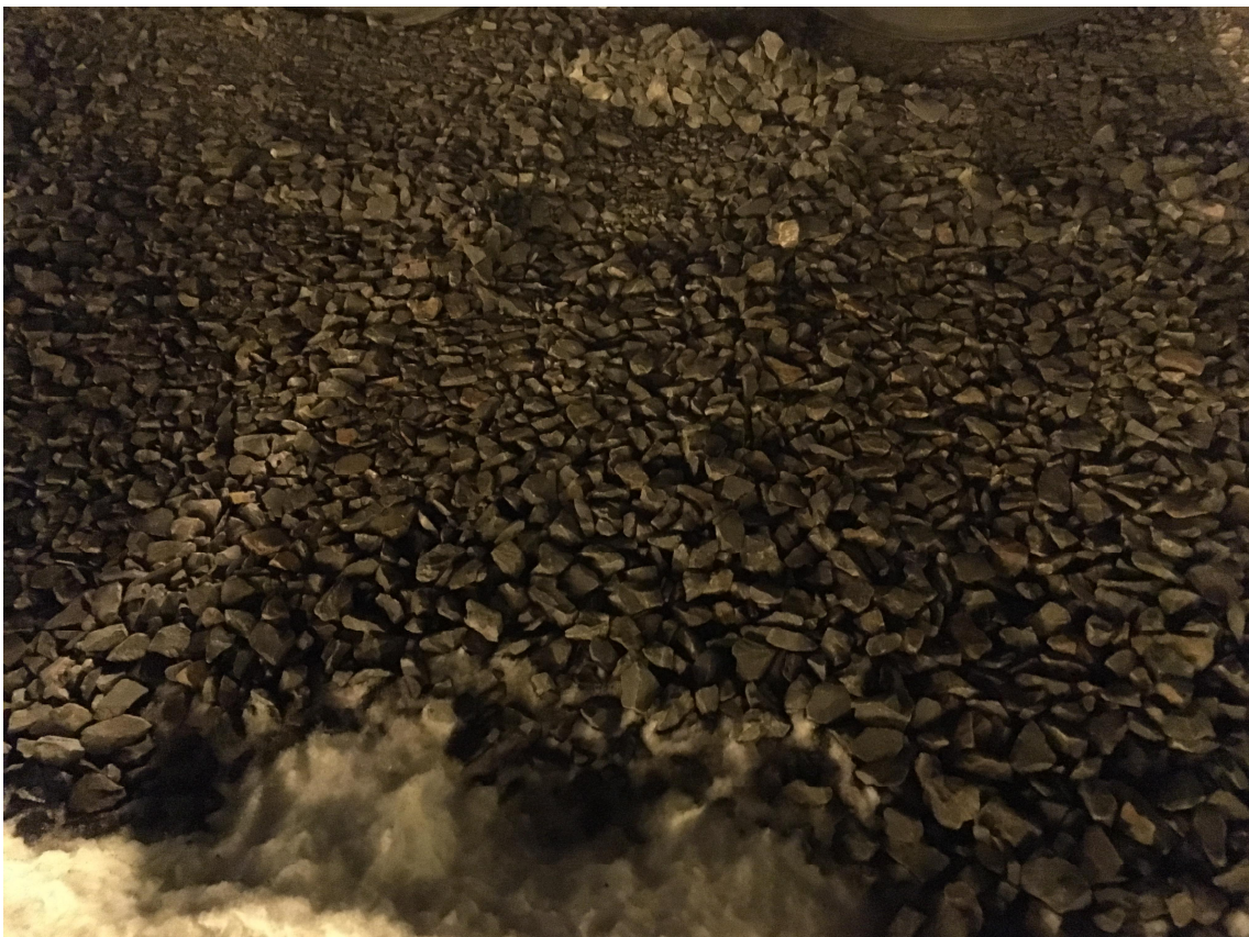
Kuva 10. Varastopaikan pohjan kivimurske.
