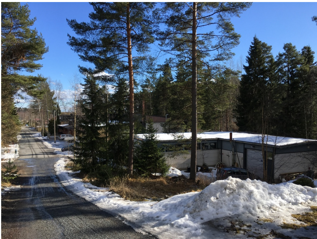
Kuva 2. Purettava hallirakennus luoteeseen.
