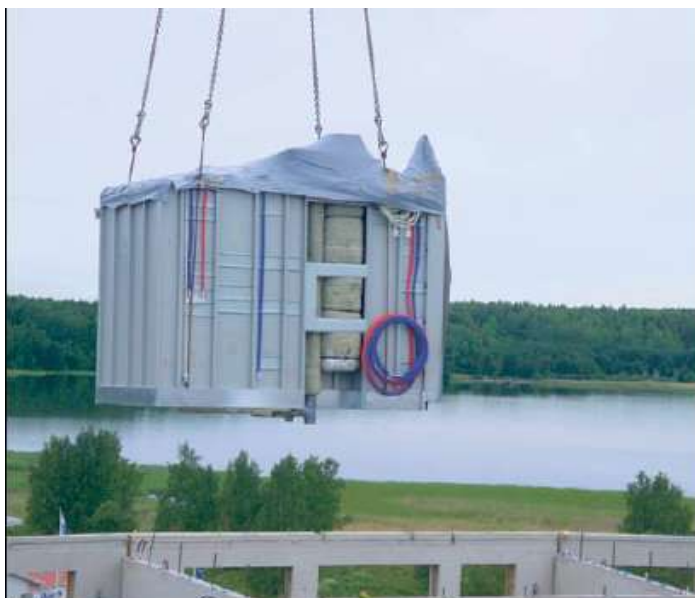
kuva 3: kylpyhuone-elementin päältäasennus (RT G82-37534)
