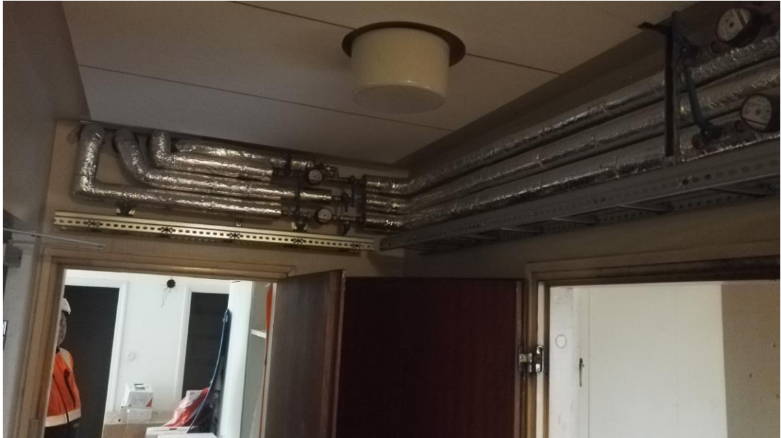
Kuva 5. Warecon työmaalla As Oy Porthaninkadulla käyttövesiputket viedään huoneistoihin rappukäytävän kautta
