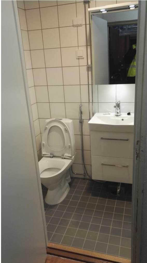
Kuva 10. As Oy Porthaninkadun kylpyhuone loppusiivousvaiheessa
