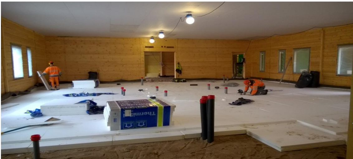
KUVA 2. Lattiastyroxin asennusta ja korkea irrotuskaista.
