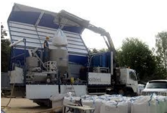
KUVA 12. Plaanon pumppausta rekasta.
