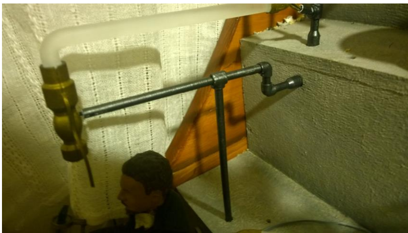
Kuva 34. Pieni putki tukirakenteineen
