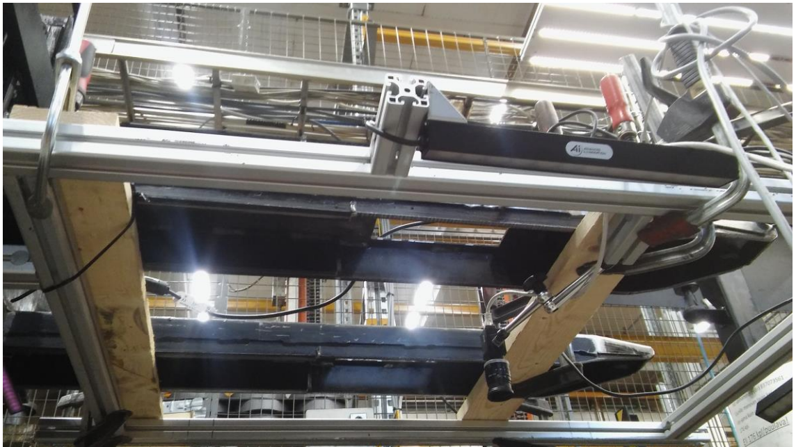
KUVA 10. Testaus infrapunavaloilla. (Tiitola, T. 2017)
