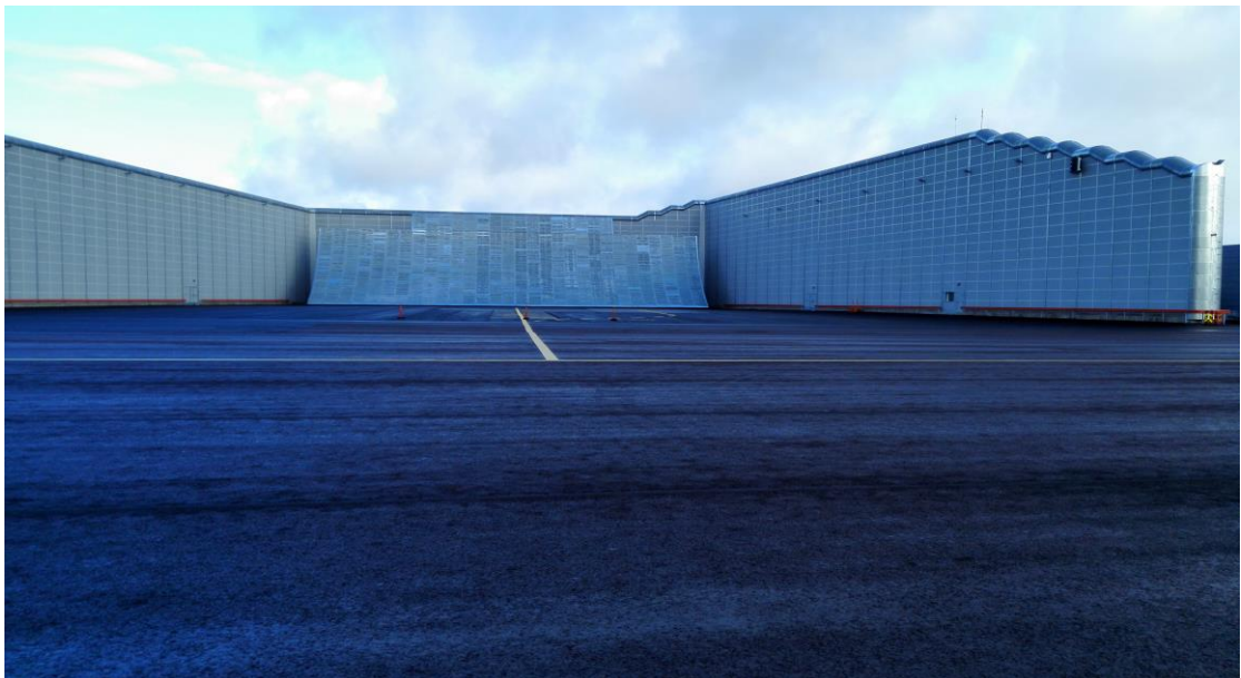
Kuva 2. Koekäyttöpaikka Helsinki-Vantaalla. GRE:n takaosassa on suihkuvirtausta varten tehty tuulielementti.
