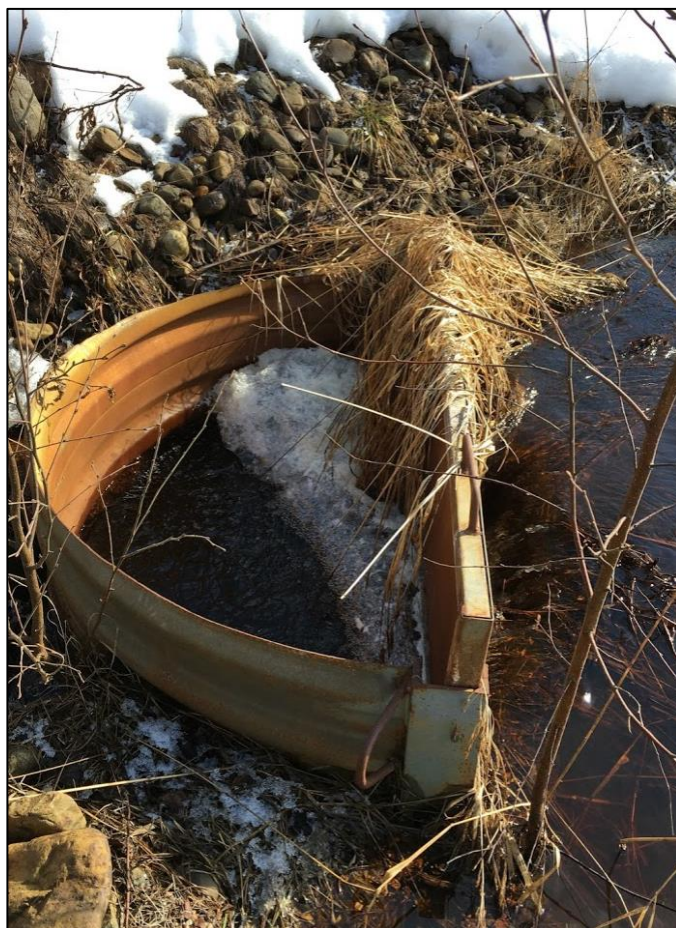
Kuva 11. Linnunsuon vanhasta laskeutusaltaasta lähtevä säätökaivo, joka johdtaa kuvan 10 tapaan lähtevään uomaan (Kuva: Laura Pehkonen).
