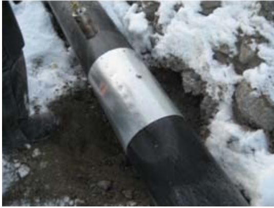
Kuvio 32: Pelti ja putki lämmitetään optimilämpötilaan.
