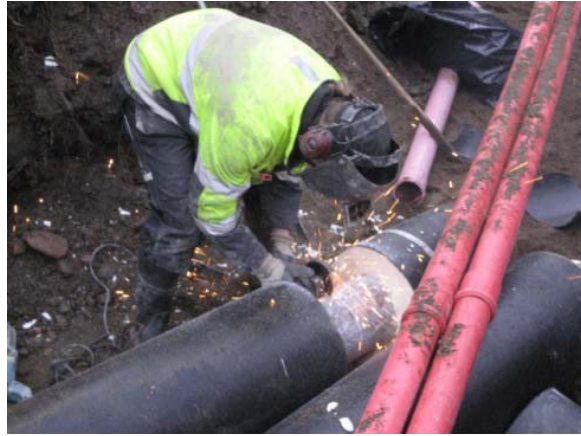
Kuvio 9: Kaivannoissa on runsaasti muita putkia ja johtoja, jotka tulee ottaa huomioon.
