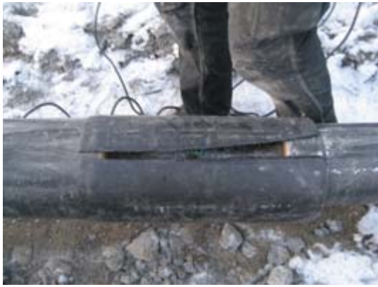
Kuvio 23: Halkaistu putki asennettuna liitoksen päälle.
