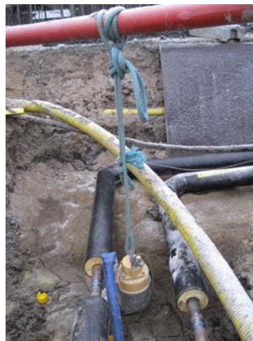
Kuvio 10: Suodattimella varustetulla oppopumpulla saadaan tarvittaessa vesi pois kaivannon pohjalta.
