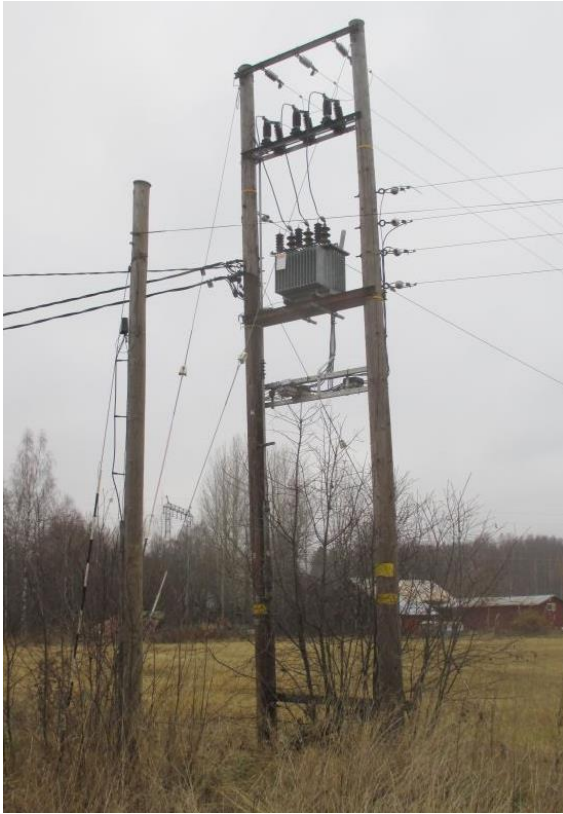
Kuvio 4. Maastotietokanassa kuvattava 20 kV pylväsmuuntamo (Kärnä 2015)
