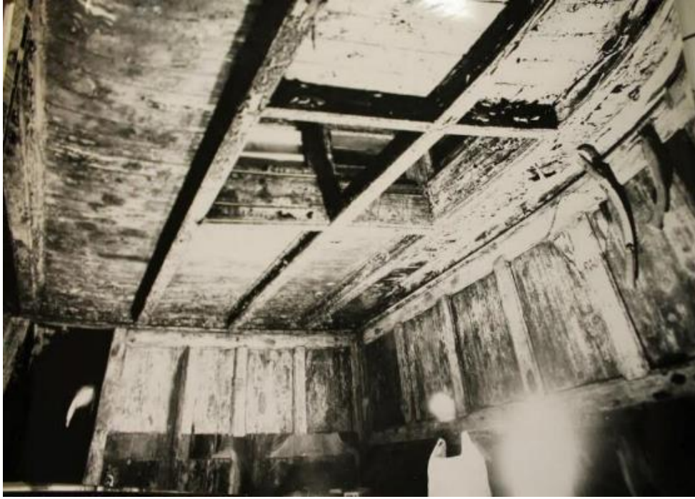
Kuva 5. Ruokasalongin katto laivan noston jälkeen. Katossa keskellä näkyy venekannelle nouseva valolaatikko. (Savonlinnan maakuntamuseon arkisto 2016)
