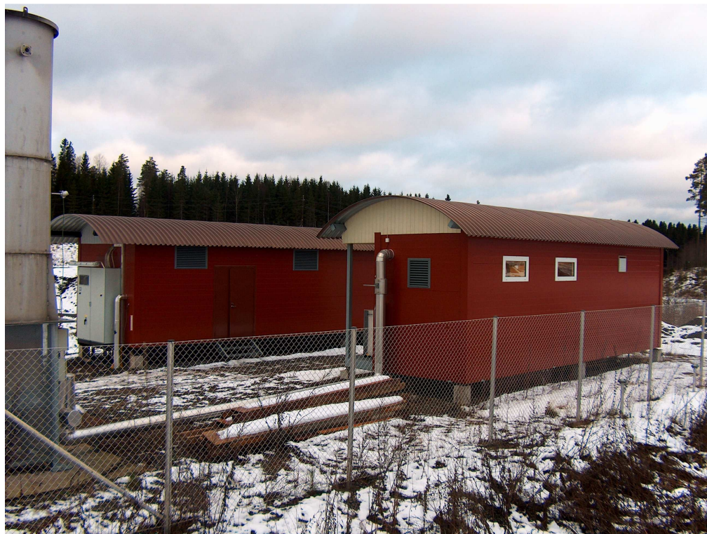
Kuva 7. Mikkelin Metsä-Sairilan kaatopaikan biokaasupumppaamo ja mikroturbiinilaitos (2005).
