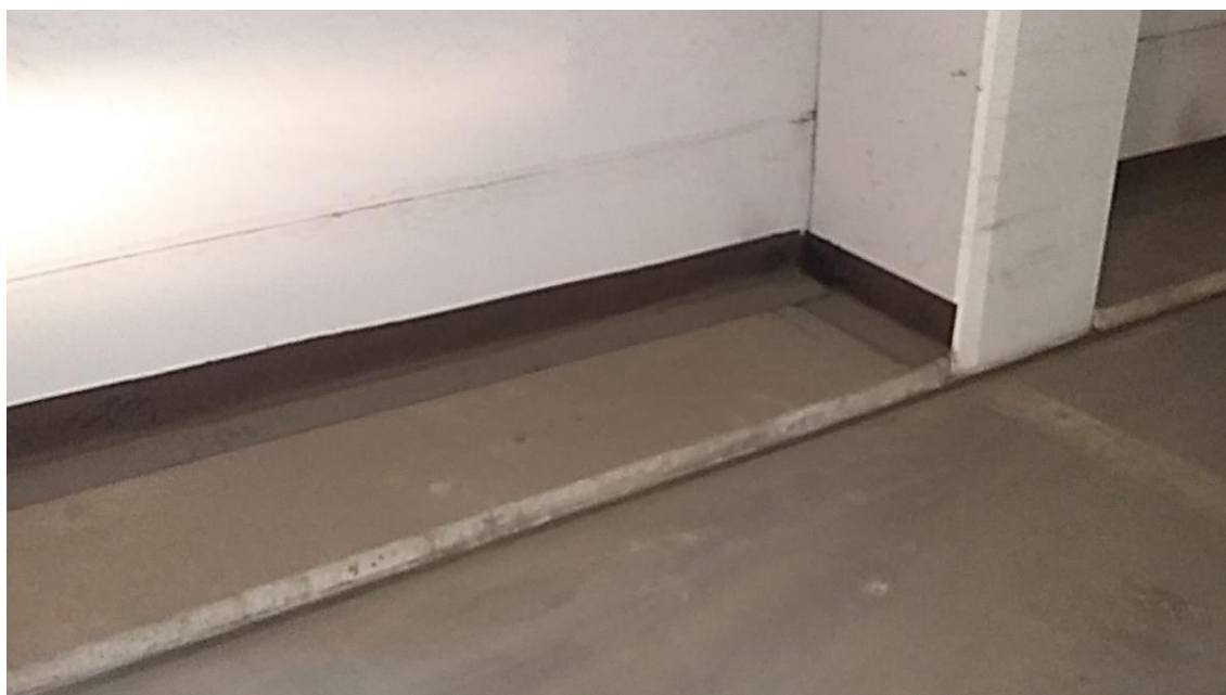
KUVA 18. Välipohjalaataston ja ulkoseinän liitoksen tiivistyskorjaus
