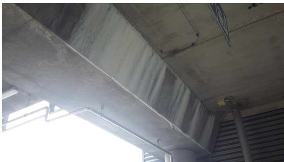
KUVA 17. Kalkkiveden valuminen on yleinen esteettinen ongelma
