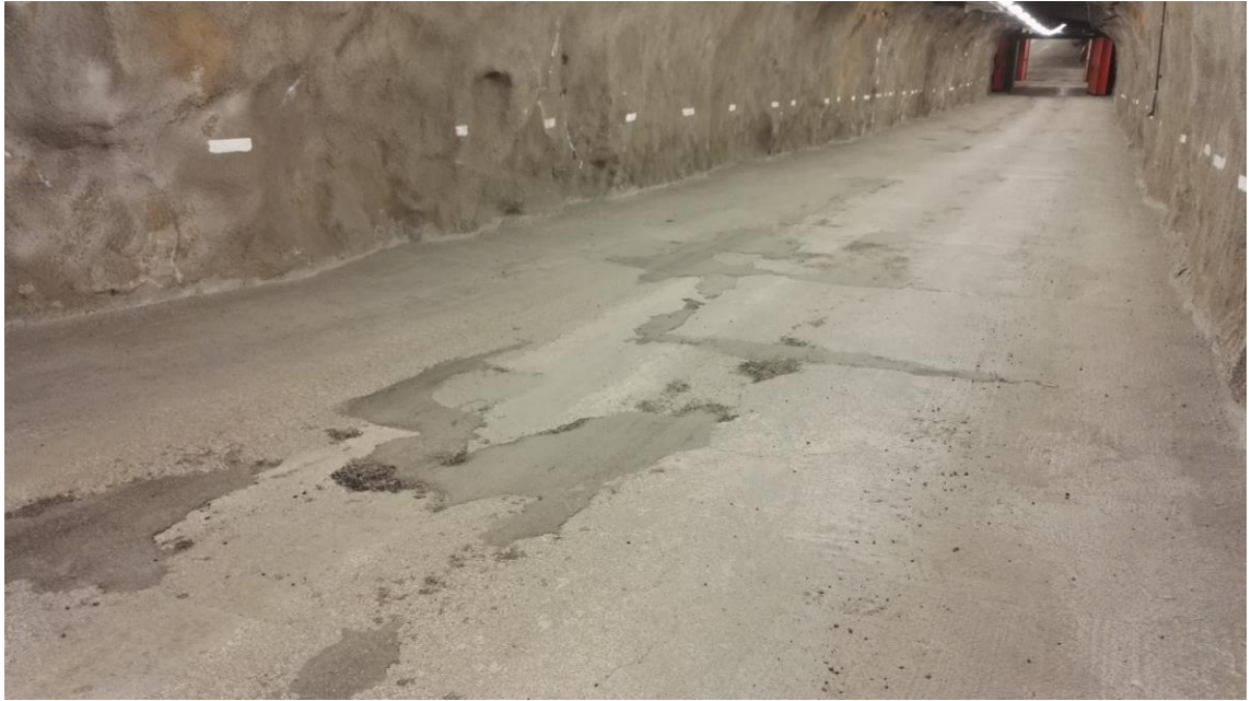
KUVA 9. Ajourampin lattiapinnan kuluma ja paikkauskorjaukset (Kuva: Jyrki Männistö 2017)
