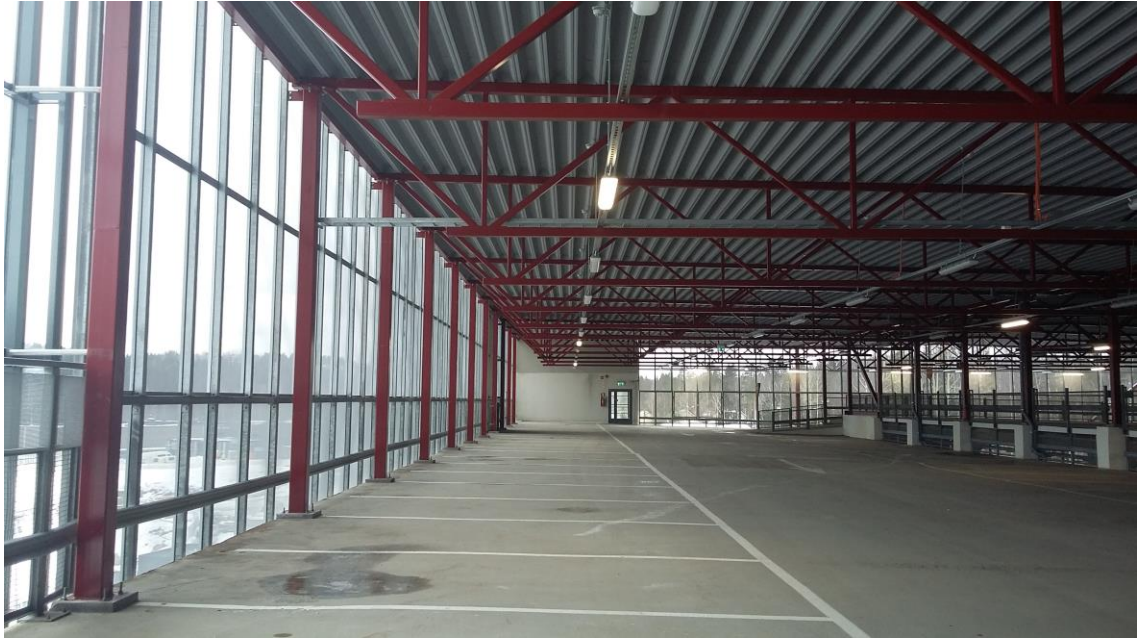
KUVA 20. Jälkikäteen katettu pysäköintitaso
