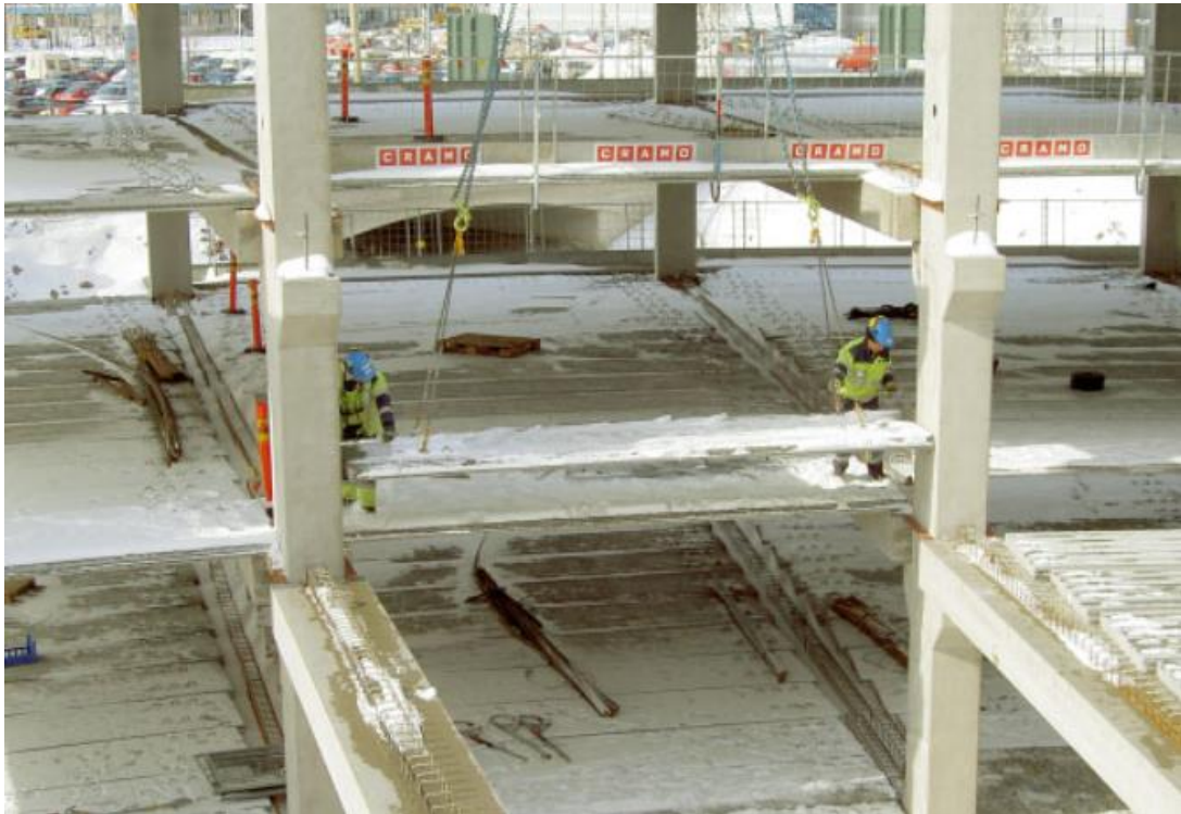
KUVA 7. Kuorielementtien asennus (Kuva: Olli Aho 2008)
