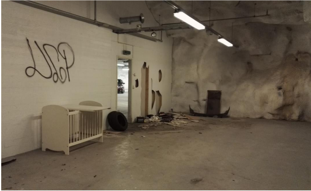
KUVA 15. Ilkivallan jälkiä pysäköintilaitokseen liittyvässä tilassa (Kuva: Jyrki Männistö 2017)
