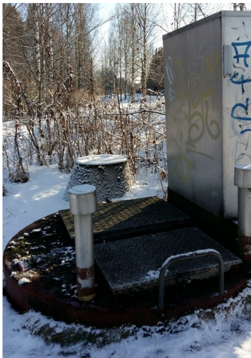
Kuva 34. Tuusulantien uoppumppaamon ulkopuoliset rakenteet.
