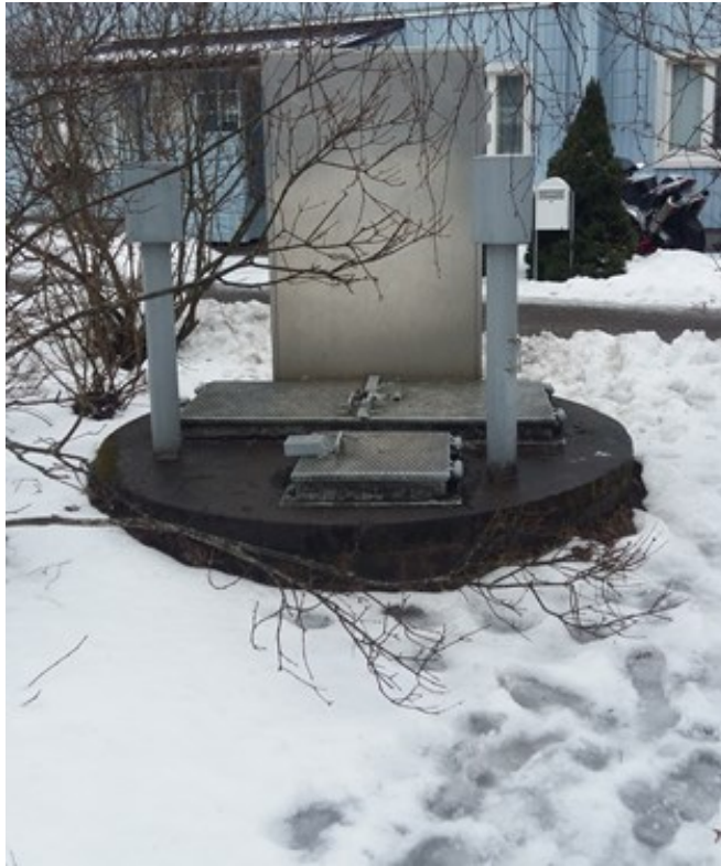
Kuva 35. Nissilänpihan pumppaamon maanpäälliset rakenteet.
