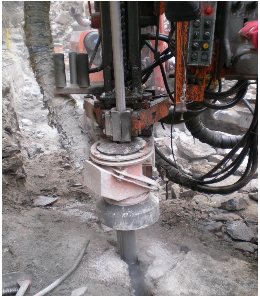
Kuva 15. Irtiporauksen viimeinen vaihe alkamassa. Työvaiheessa käytettävä konkka avartaa tärinää hyvin johtavat kalliokannakset pois. [11]
