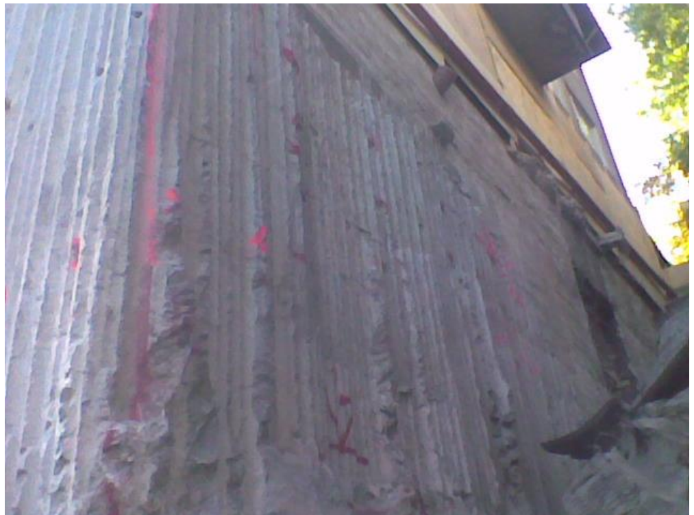
Kuva 16. Irtiporausseinämä louhinnan jälkeen. Rakennuksen perustusten alainen kallio on jäänyt ehjäksi. [12]
