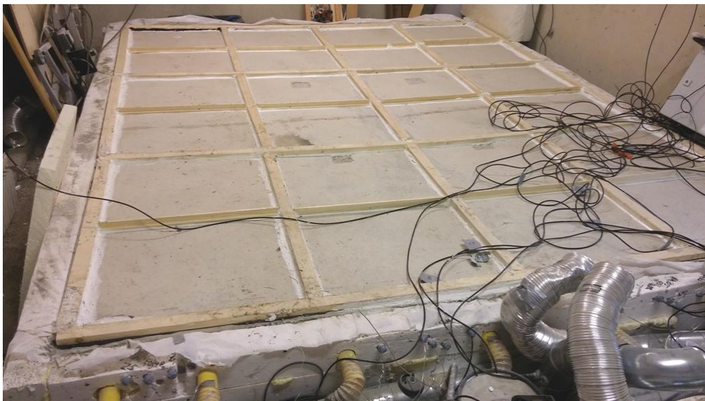
KUVA 2. Puurimat asennettuna laatan päälle.
