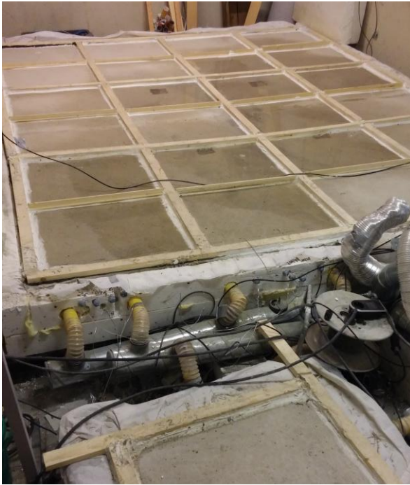
KUVA 5. Vesi imeytyi tutkimuslaatalle epätasaisesti rimoituksesta huolimatta.
