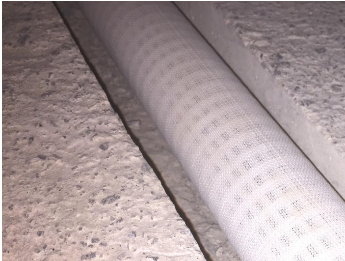
KUVA 1. Tulilattiaputki uritettu laattaan.
