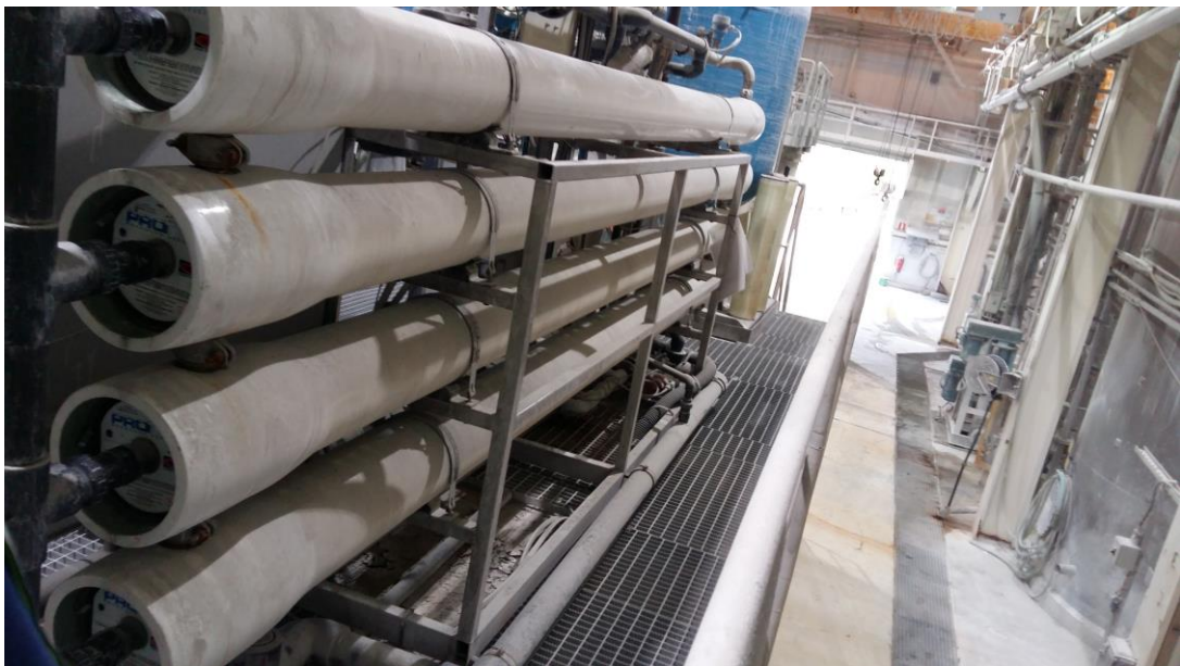
Kuva 19. RO-moduulit. [1.]
