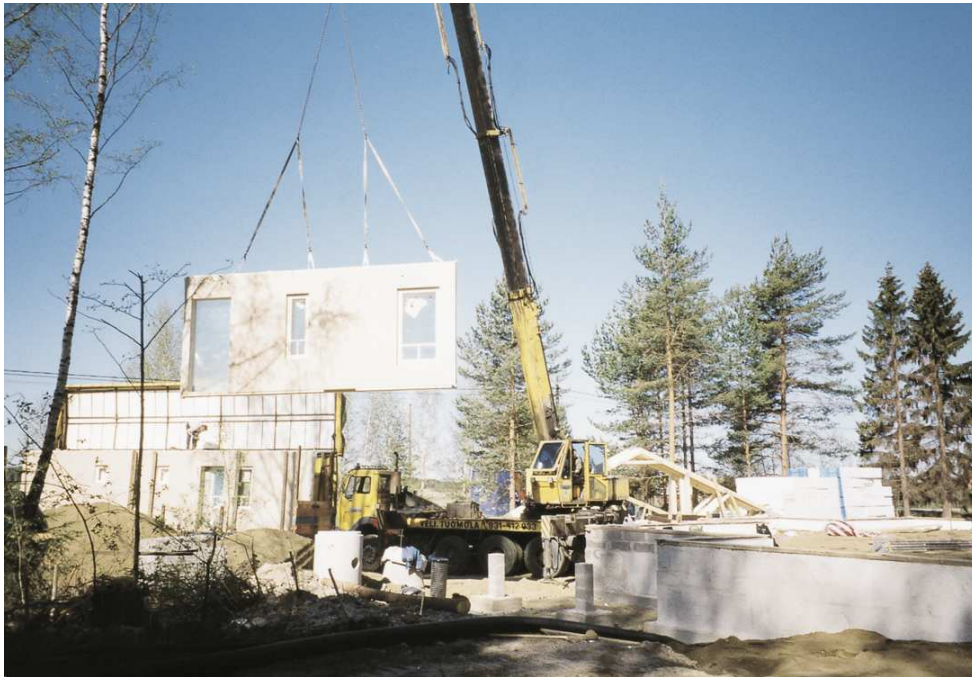
Kuva 2. Suurelementin asentaminen vaatii nosturia (7.)
