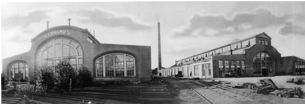
Kuva 8. Konepaja- ja valimorakennus. (Metso, Kuva 1920-luvulta)
