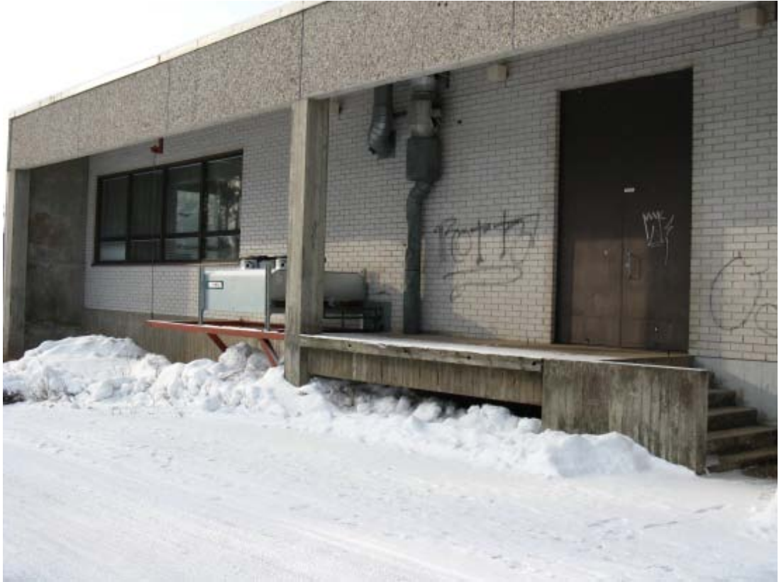
Kuva 14. Lauhdutin asennettuna sijoituspaikkaansa.
