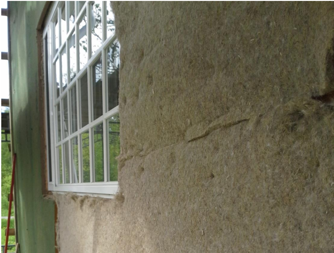
Kuva 8. Pellavaeristeen ja tuulensuojalevyn asennus seinään
