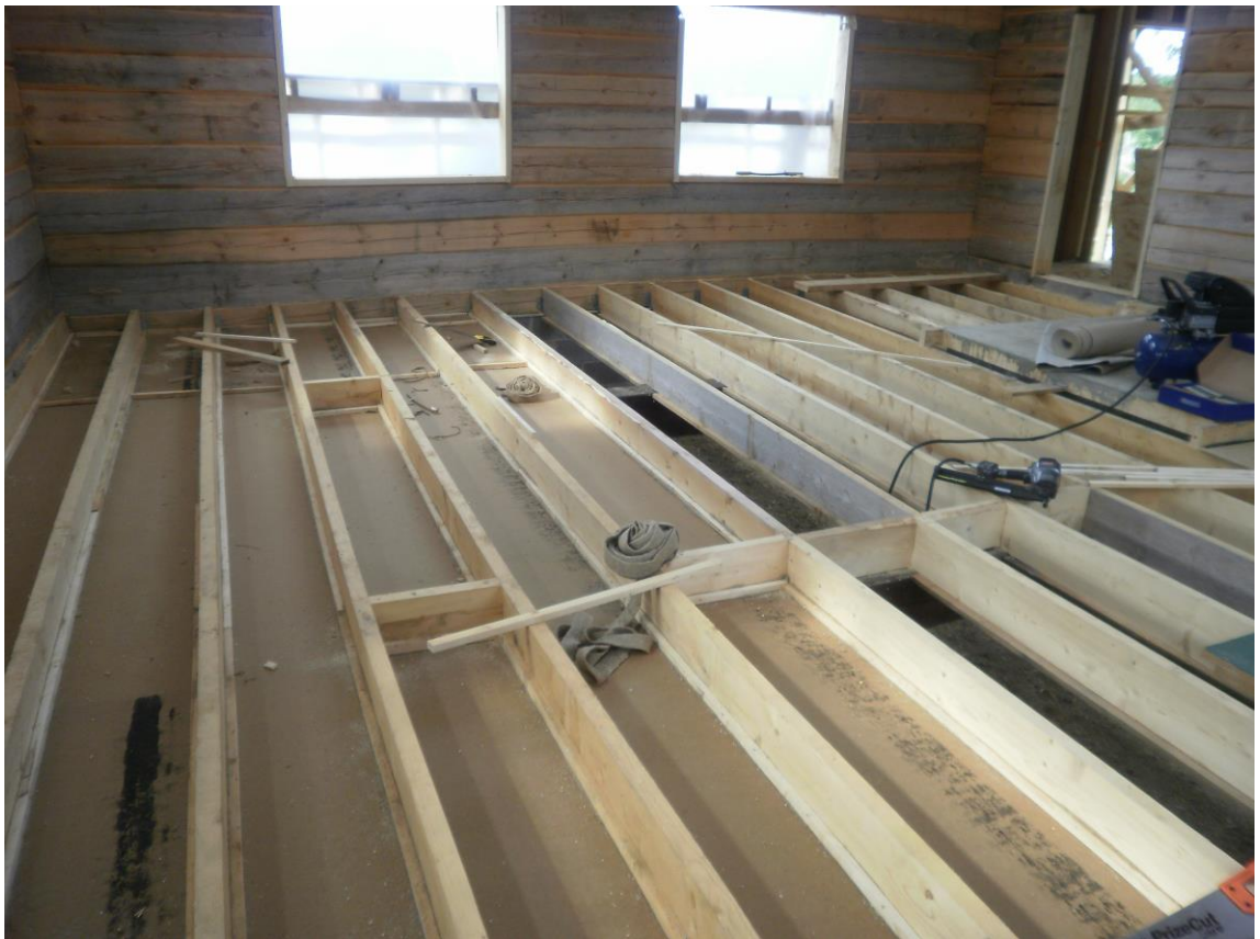
Kuva 1. Tuulettuvan alapohjan lattiarunko asennettuna.
