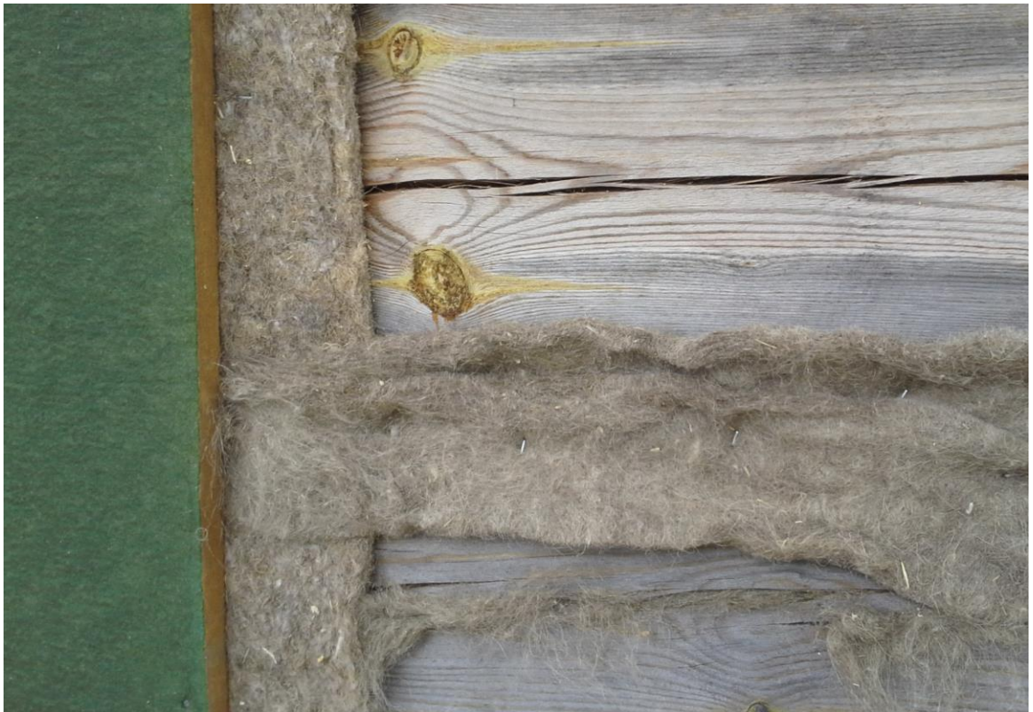
Kuva 9. Hirsien varaukset ja halkeamat tilkittiin ennen maton asennusta.
