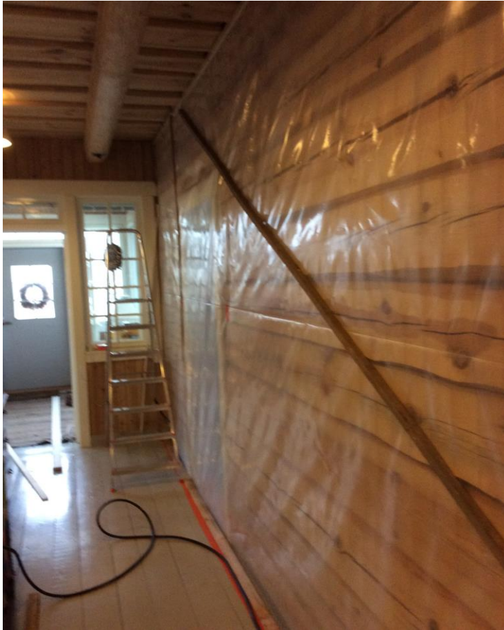
Kuva 13. Mitattavien rakenteiden erottaminen muista tiloista.
