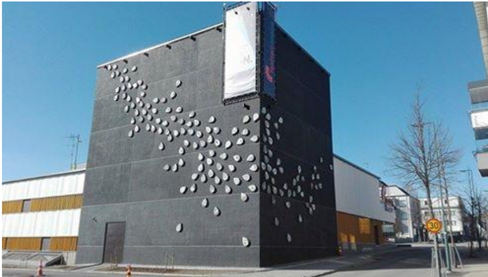
Kuva 2. Teatteri Imatran julkisivu
