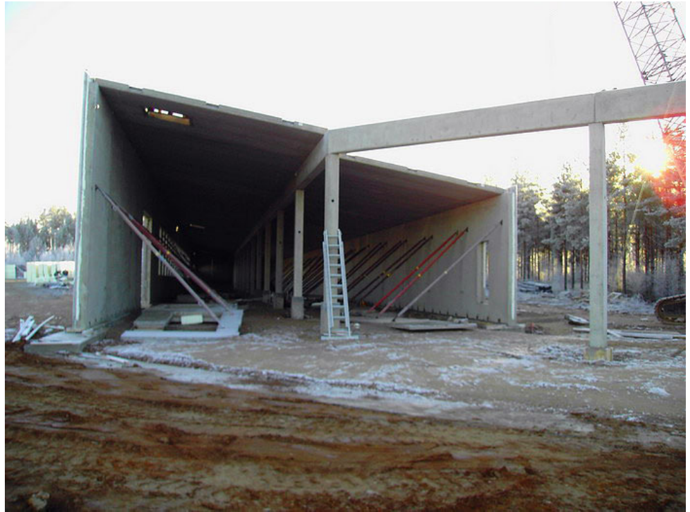
Kuva 14. Lapesuunta aurinkoon aiheuttaa lämpötekni- sen ongelman putkessa [6]
