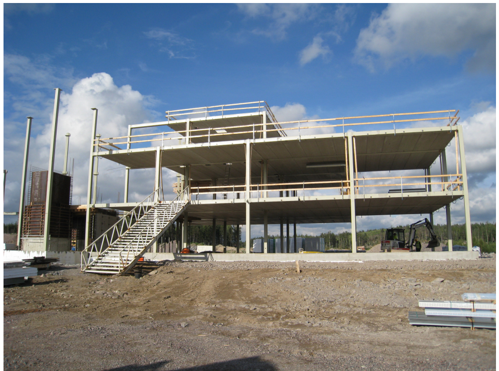
Kuva 19. Putoamissuojauksen järjestäminen ja kulkutie [11]
