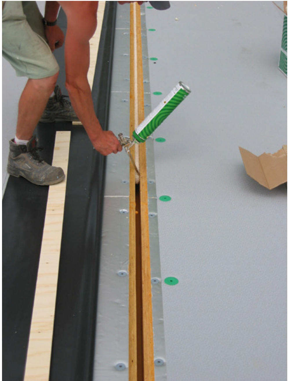
Kuva 7. Kattoelementin sauman eristäminen [10]
