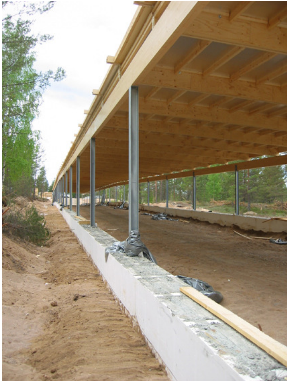
Kuva 5. Rungon rakenneratkaisut [10]
