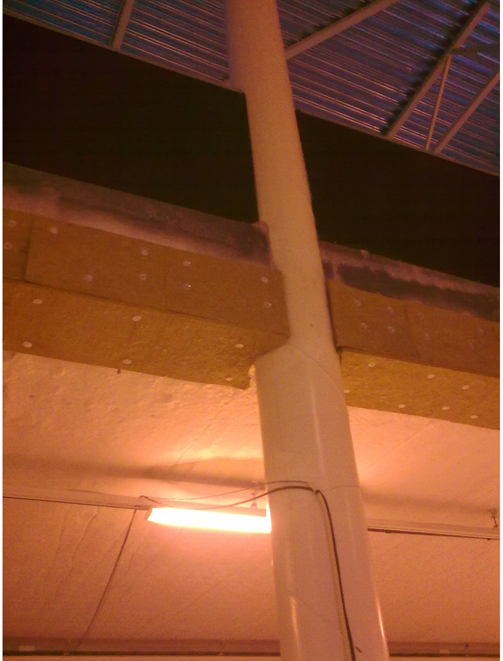
Kuva 16. Hiihtohyllynrunгон palosuojaus
