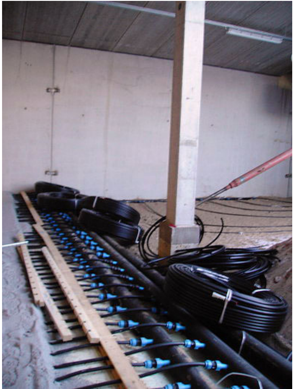
Kuva 12. Jäähdytysputkisto asennusvaiheessa [6]
