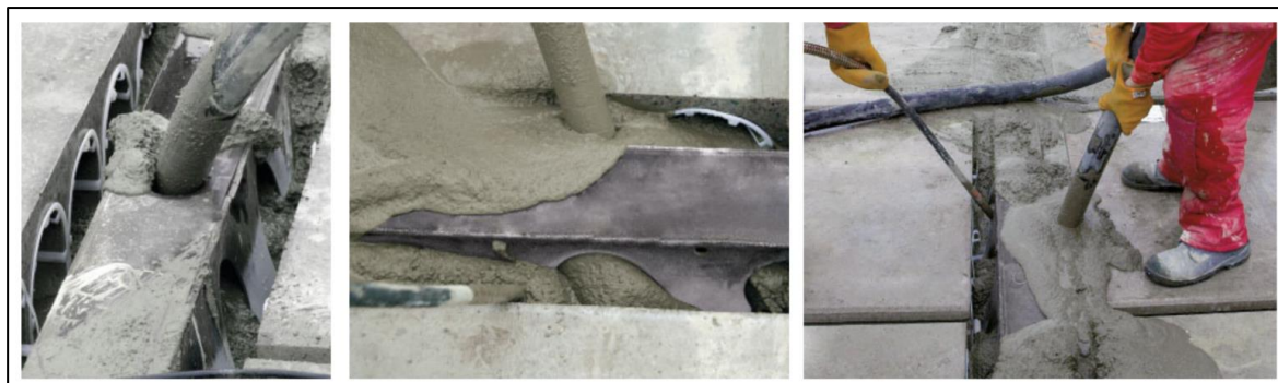
Kuva 6. Deltapalkin betonoiminen.
