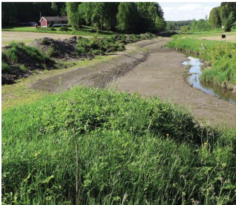
Figur 4. Dike med en anlagd terras och bevarad mittenfåra.
