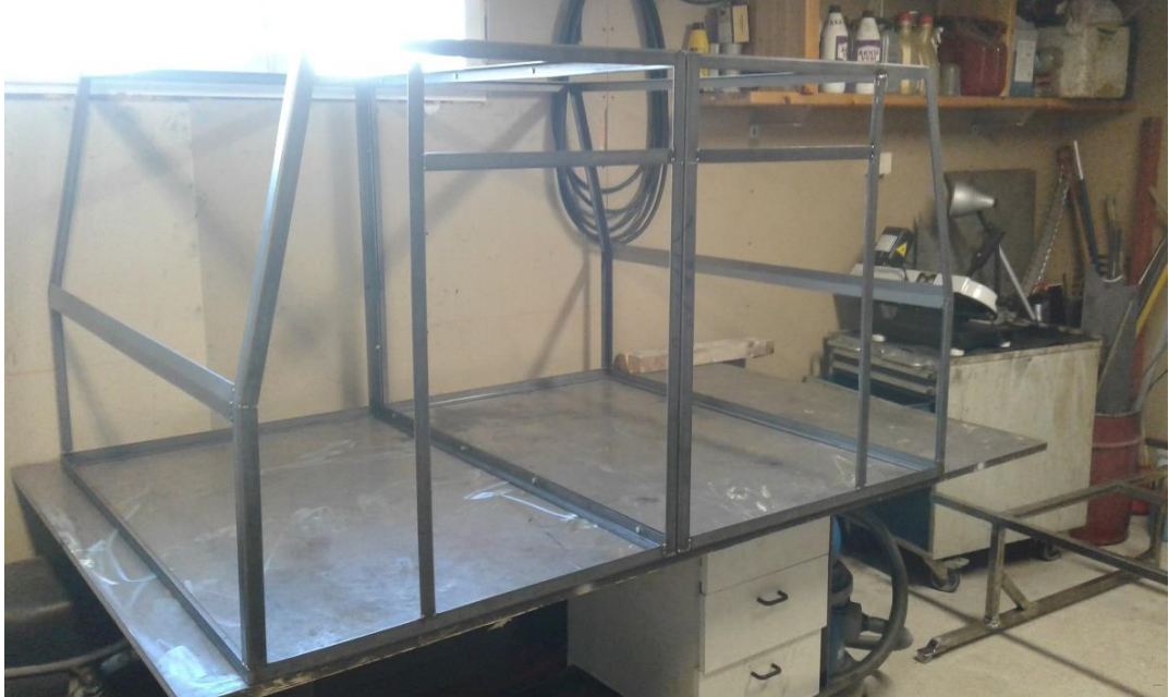
Kuva 21. Oven karmit paikoillaan.
