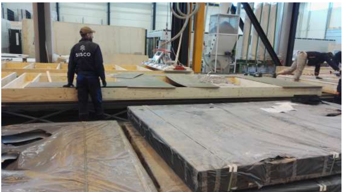
Kuva 20. Eristepuhalluskone takana ja osittain puhallettu suurelementti edessä.
