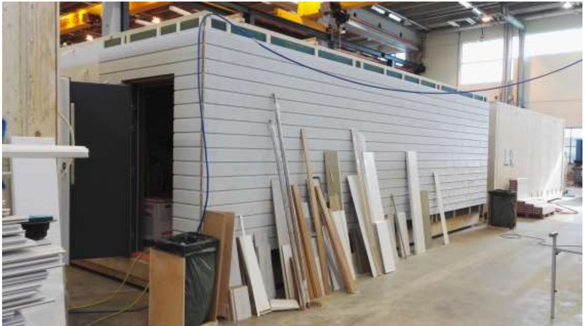
Kuva 24. Eri rakennusvaiheessa olevia tilaelementtejä.
