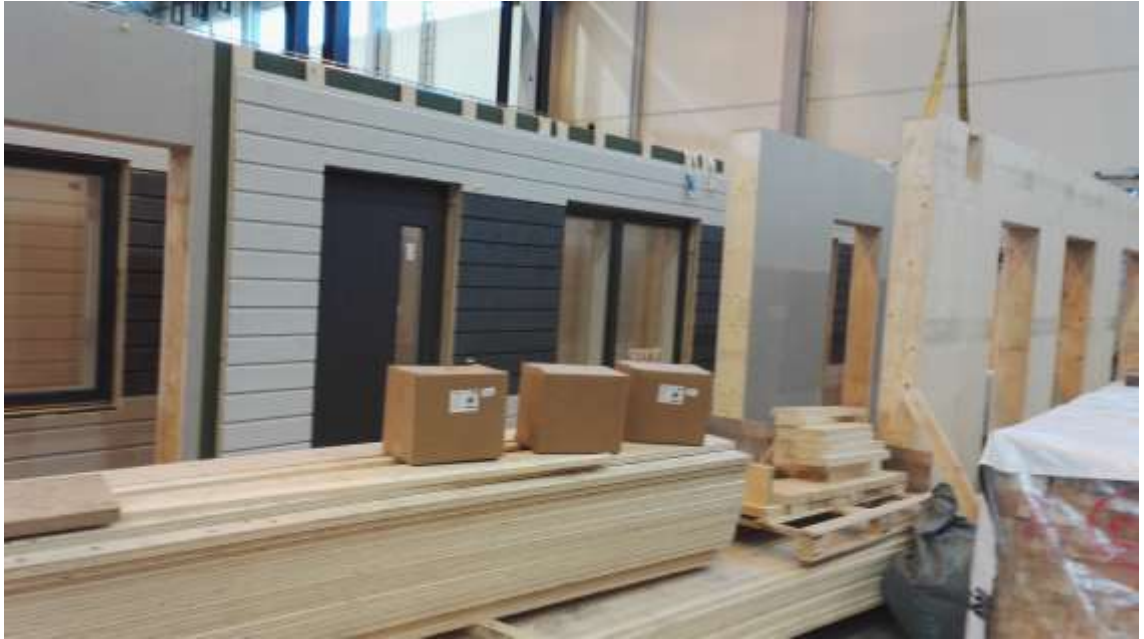
Kuva 22. Ovien ja ikkunoiden asennus.
