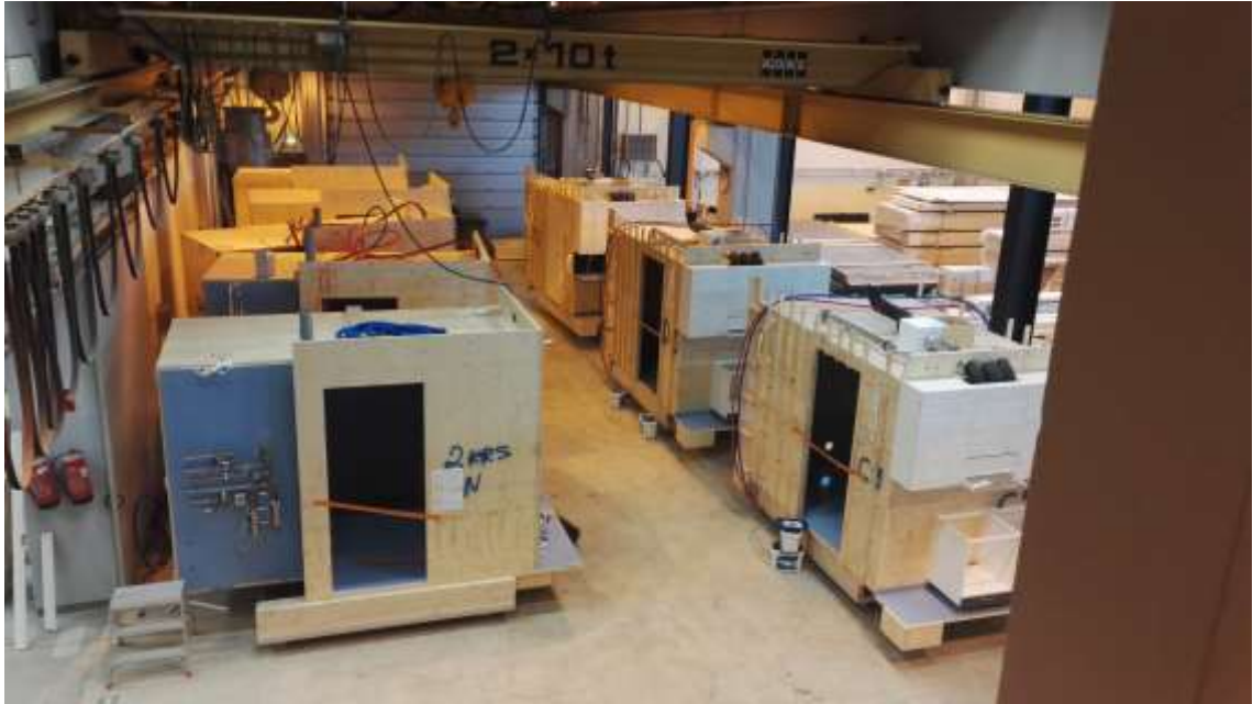
Kuva 23. Eri rakennusvaiheessa olevia kylpyhuone-elementtejä.
