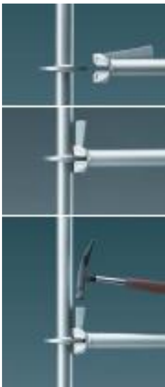
Kuva 3. Allround-telineen kiilaliitos. /3/
