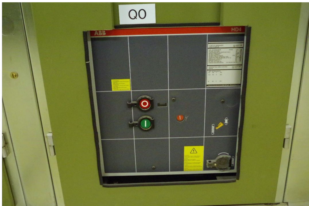
KUVA 9. ABB HD4 SF 6 -täytteinen katkaisija (Määttä, 2017.)
