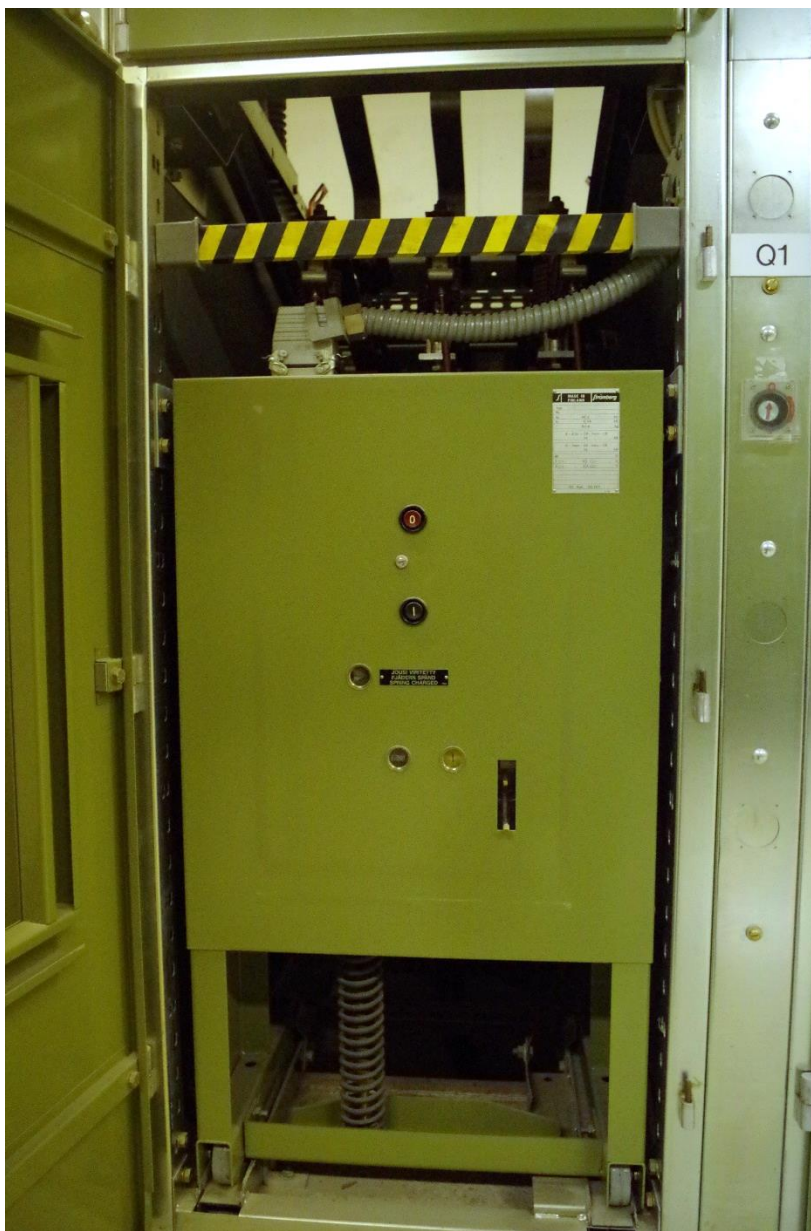
KUVA 10. Strömberg OSAM 12 A3 -vähäöljykatkaisija (Määttä, 2017.)
