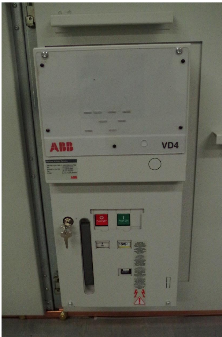
KUVA 8. ABB VD4 tyhjiökatkaisija (Määttä, 2017.)
