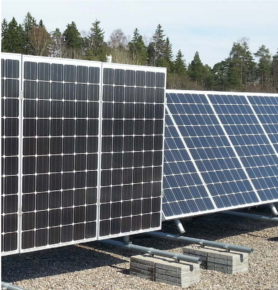
Kuva 10. Kallistuskulmaan 90^\circ asennettu paneeli varjostaa viereistä 60^\circ :n kallistuskulmaan asennettua paneelia, kun aurinko säteilee lännestä.
