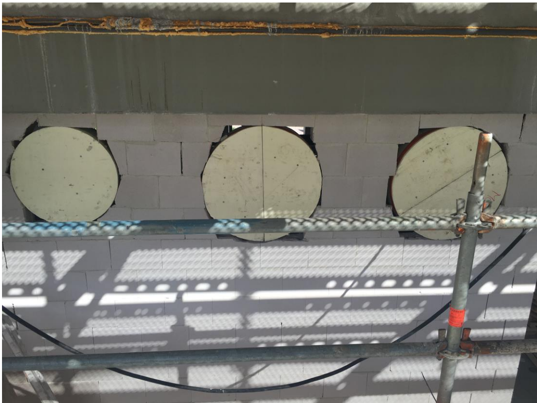
Kuva 3. Muuravaiheessa on jätetty reikävaraus palopellin asennukselle palopelti valmistajan ohjeiden mukaisesti. Kuva on pilottikohteesta.
