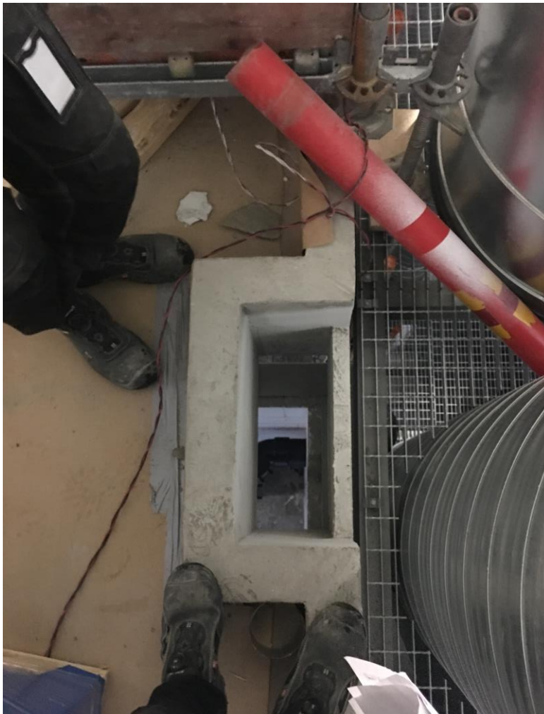
Kuva 4. Sähkön läpivienti. Kuva on pilottikohteesta.
